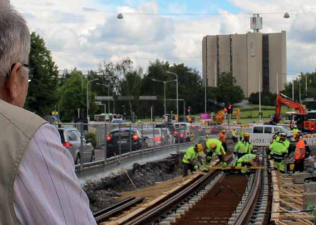
KUVA: Itsenäisyydenkadulla pian valmistuva raitiotie. Kalevan kirkon kohdalla raide erkaantuu kahteen haaraan, päätepysäkkeinä TaYS ja Hervanta. Valokuva Raitiotieallianssi / Susanna Lyly, 2017.
