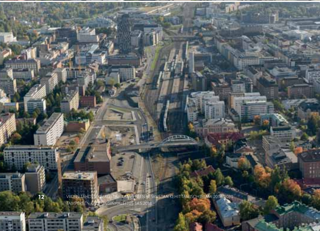
KUVA: Tampereen keskustan halkaiseva leveä rautatiealue. Korkean rakentamisen ja kaupunkikannen vyöhyke: Kansi ja Areena, Asemakeskus, Ratapihankadun yritysalueet. Työmaana PMK:n torni, Luminary ja Technopoliksen tontti. Viistoilmakuva Tampereen kaupunki / Lentokuva Vallas, 2017.
