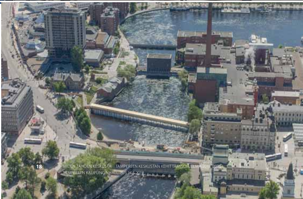
KUVA: Hämeensilta remontissa ja väliaikainen kävelysilta yli Tammerkosken. Viistoilmakuva Tampereen kaupunki / Lentokuva Vallas, 2018.
