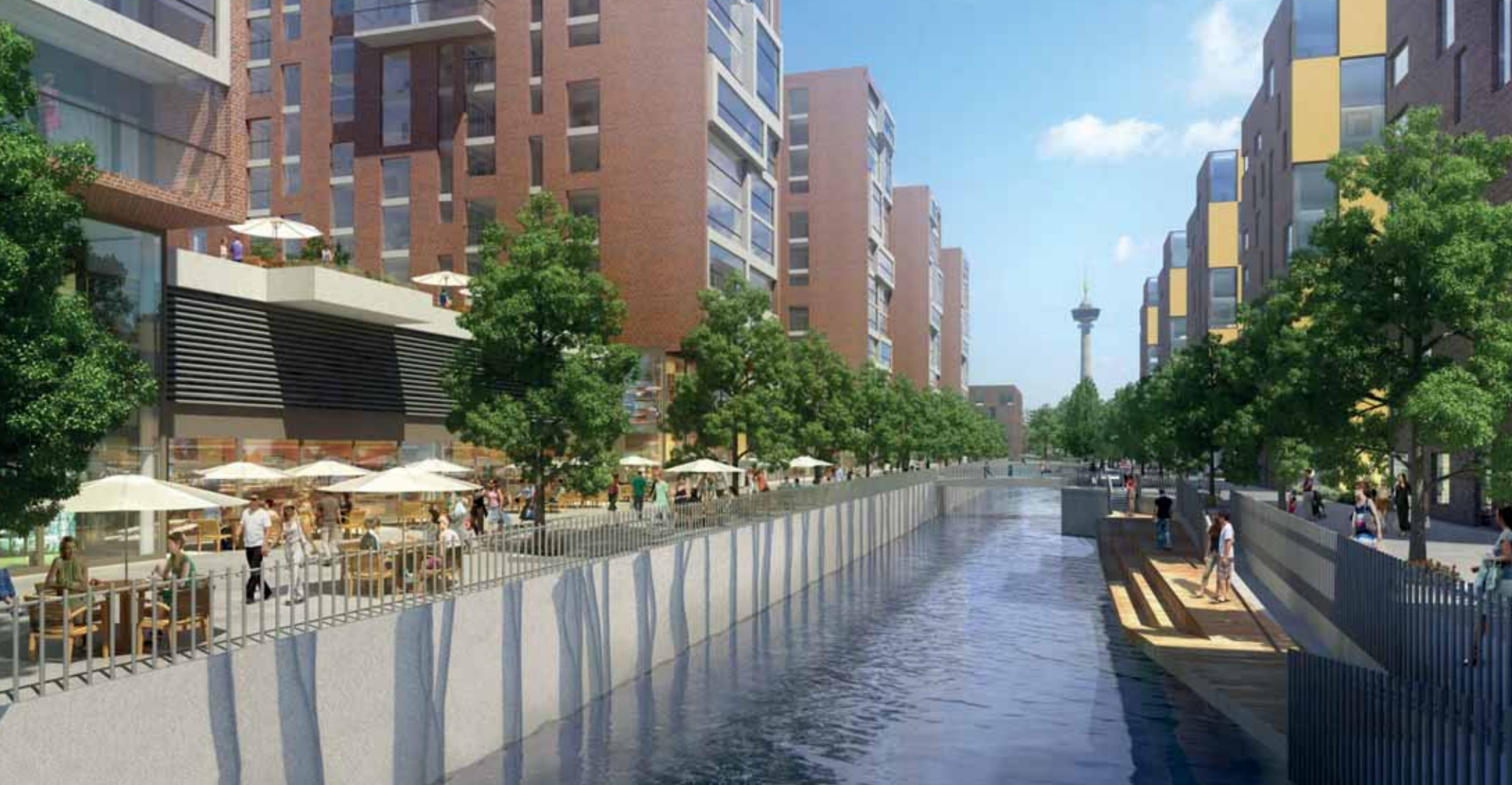
KUVA: Ranta-Tampellan kanava. Rakentaminen käynnissä 2018. Kuva Tampereen kaupunki / Havainnekuva YIT Rakennus Oy, 2017.
