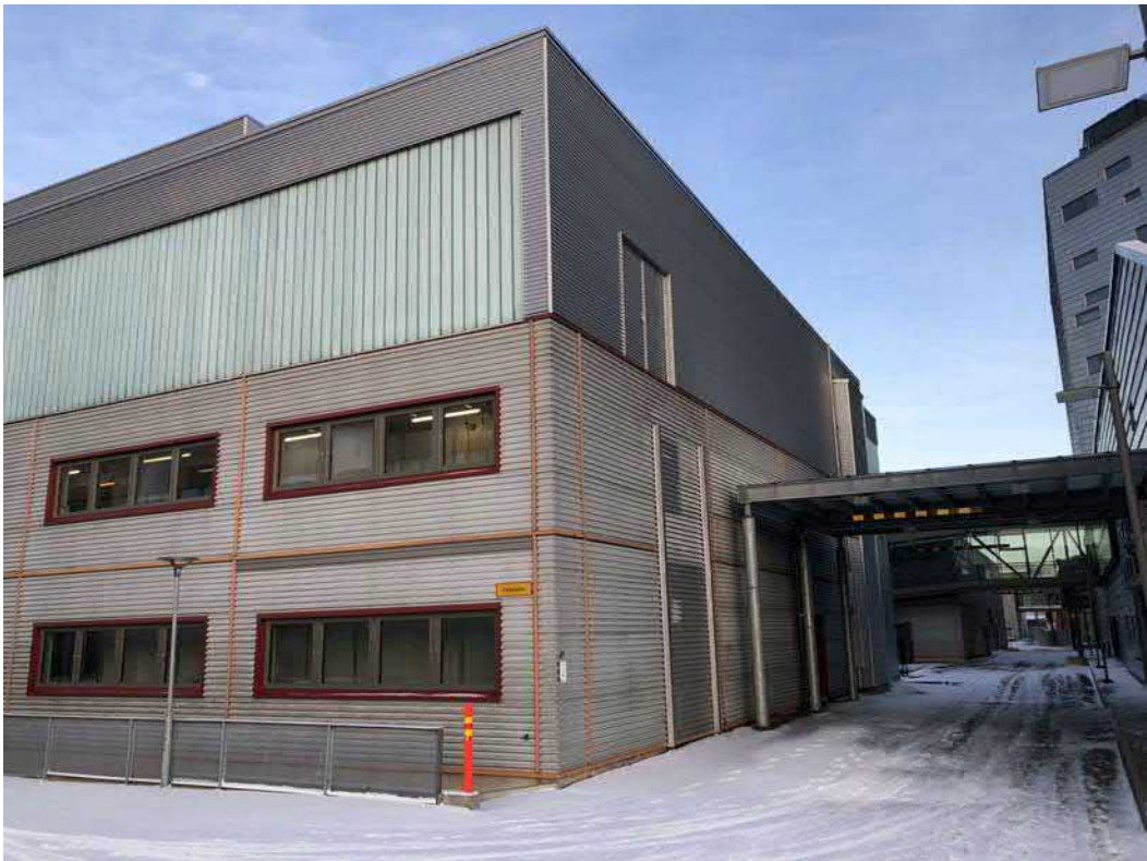
Kuva 31. Sähkötalon lounaiskulma. Katolla on uusi konehuone.
