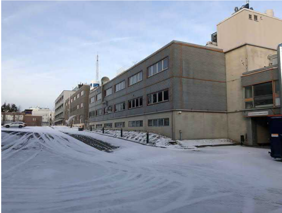
Kuva 24. Sähkötalon länsisivua etelästä katsottuna.
