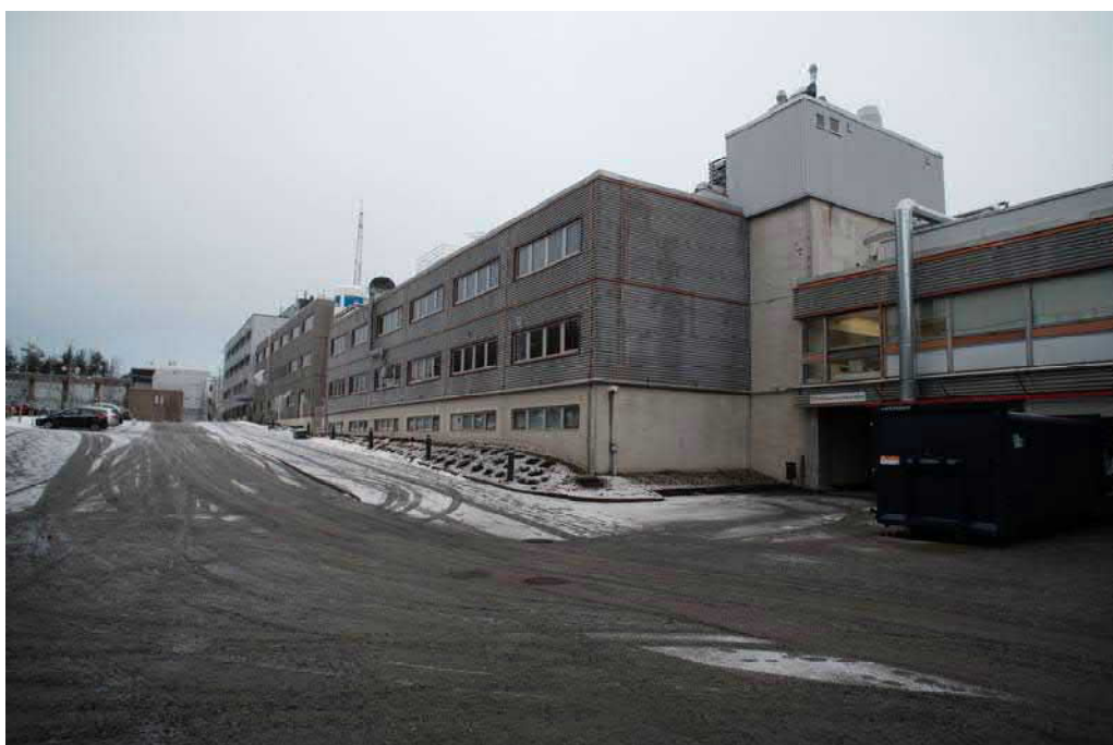
Kuva 18. Nykytilanteen kuva, jonka avulla voidaan havaita kuvan 17 ottopaikka. Ajan patinan (alumiinin hapettumisen) myötä seinän loistokkuus on himmentynyt. Ilmanvaihtokonehuone-kontti on maalattu vaaleaksi. Kuva Aihio Arkkitehdit Oy, Konsta Ryösä.
