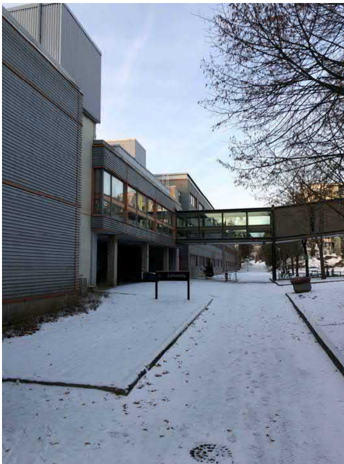
Kuva 27. Sähkötalon itäisivua etelästä katsottuna.
