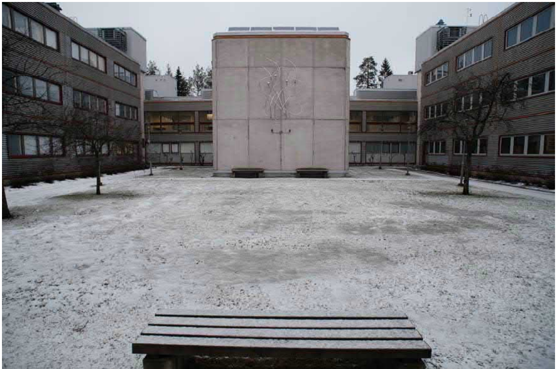
Kuva 39. Akustinen laboratorio, jonka seinälle on tehty taideteos. Sarkofagimainen kuutio yhdessä penkkien kanssa luo tilasta lähes sakraalimaisen hiljentymispaikan.
