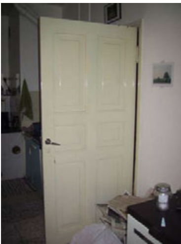
Kuva 113 Huoneistojen sisäovet ovat peitto-maalattuja peiliovia
