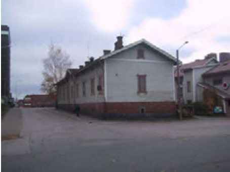
Kuva 73 Rakennuksen pääty pohjoiseen
