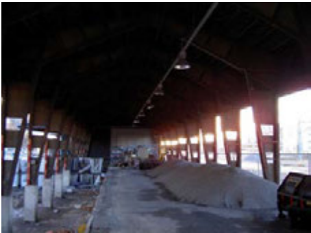
Kuva 38 alhaalla vasemmalla Laiturikatos, kantavana runkona liimapuupilarit ja -palkit
