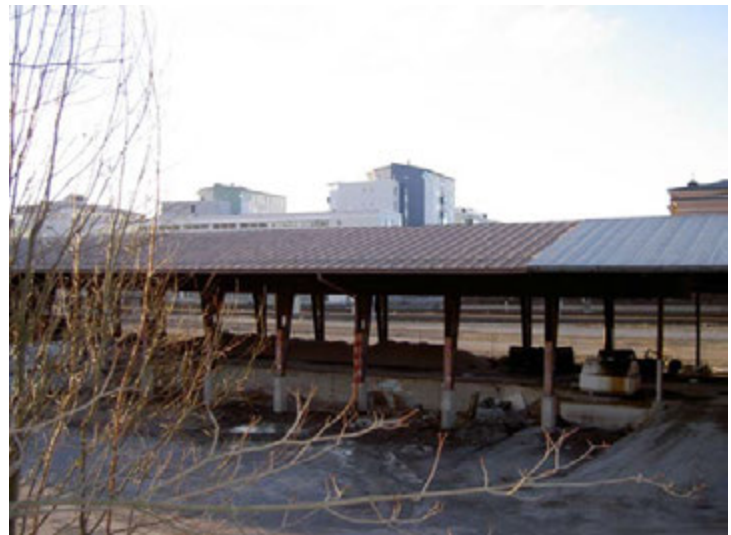
Kuva 39 alhaalla oikealla Eriaikaisten laiturikatosten jatkoskohdassa vaihtuvat katemateriaali ja rakennetekniikka
