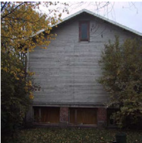
Kuva 51 alhaalla Morkun laajennusosan pääty
