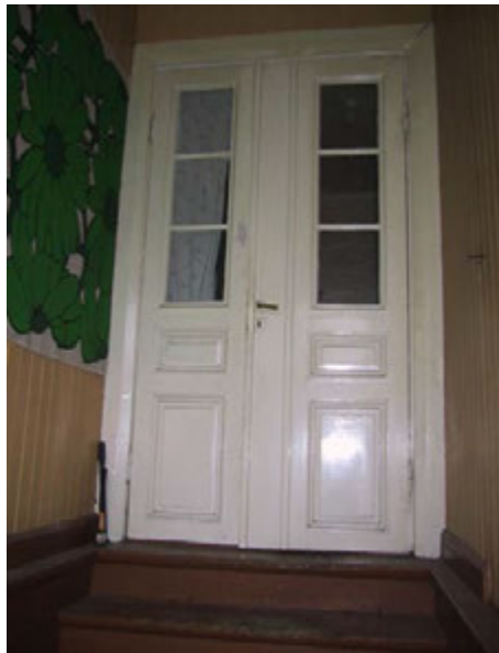
Kuva 85 Lasiaukollinen paripeiliovi portaiden yläpäässä
