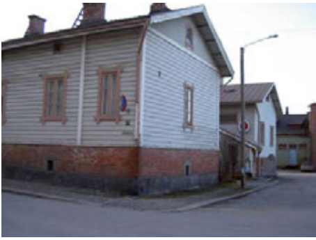
Kuva 72 Murtokadun ja Vellamonkadun kulma
