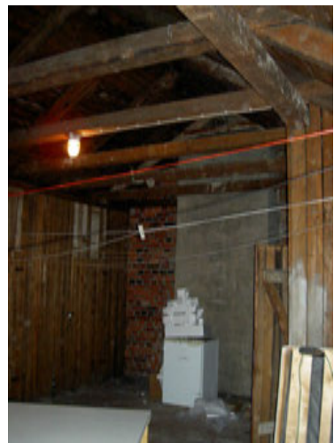
Kuva 115 Rakennuksessa on korkea avoin kylmä ullakko
