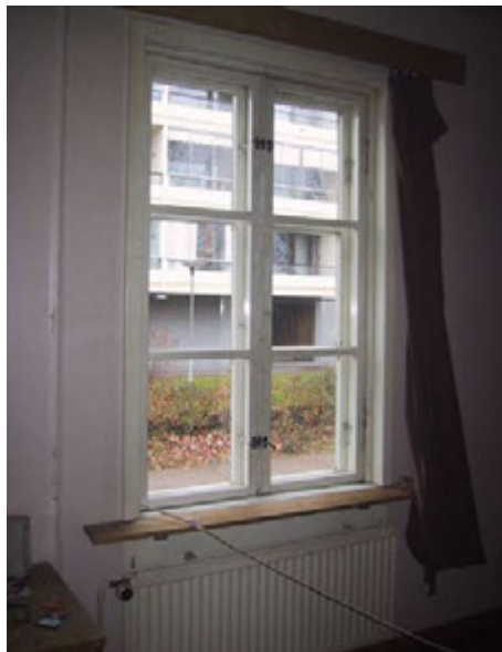
Kuva 87 Asuinhuoneiston ikkuna sisäpuolelta
