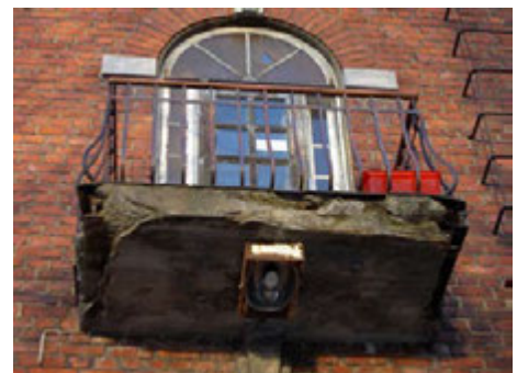
Kuva 95 Parveke pihanpuolen sisäänkäynnin päällä
