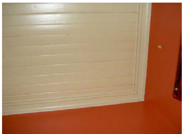
Kuva 118 Asunnon eteisen peittomaalattu paneelisisäkatto
