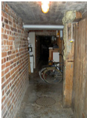
Kuva 114 Näkymä kellarikäytävästä. Kellarissa on asuntojen irtaimistovarastot.
