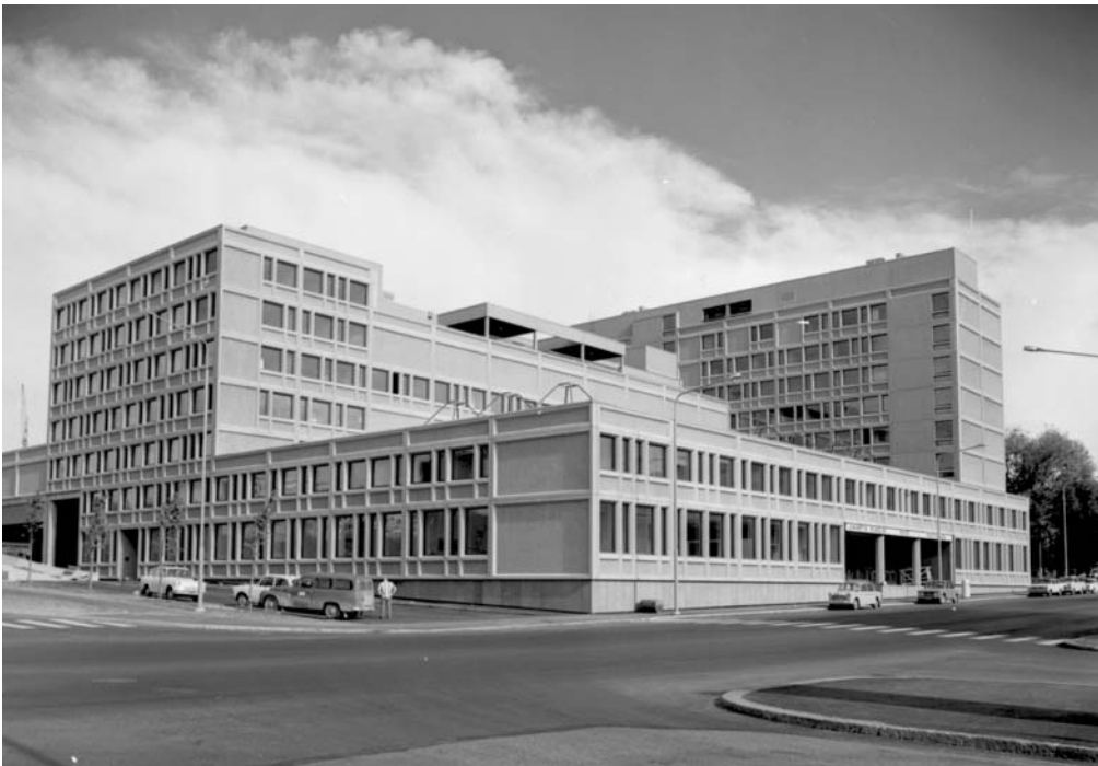
Postitalo 1971, länsi- ja pohjoisjulkisivu
