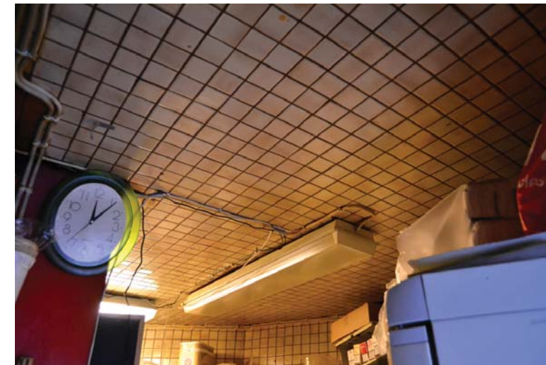
Kuva 52. Katto eteisestä kuvattuna. Katto on laatoitettu samalla kellertävällä laattalla kuin ulkoseinät.
