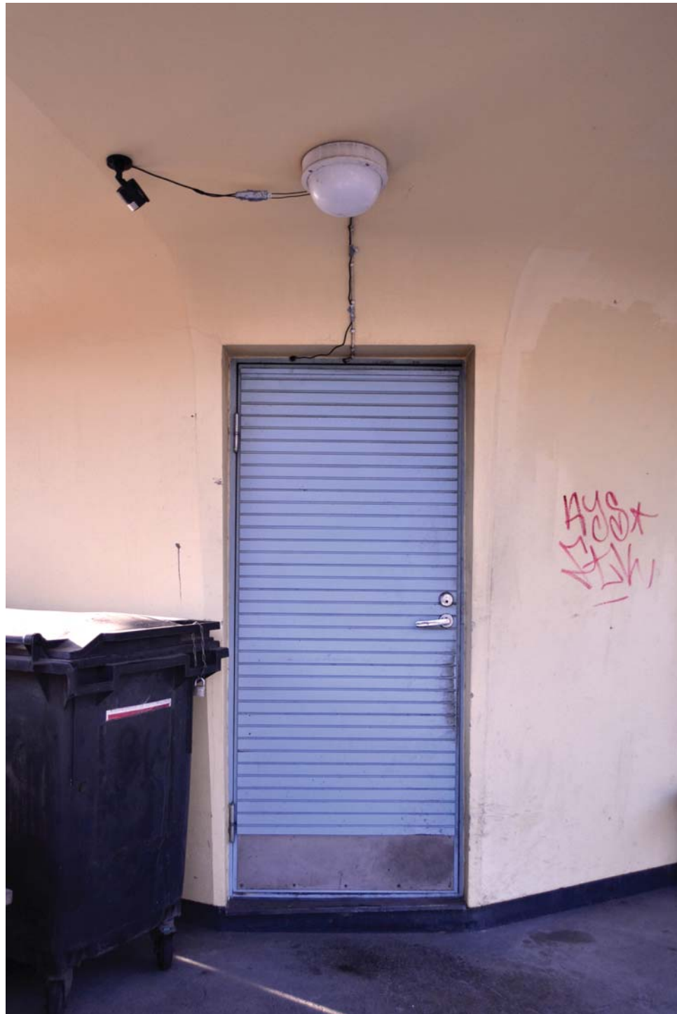
Kuva 24. Rakennuksen uusi vaaleansiniseksi maalattu puinen ulko-ovi. Yläpuolella valaisin ja musta valvontakamera. Ulkoseinän graffiteja on puhdistettu ja peittomaalattu.
