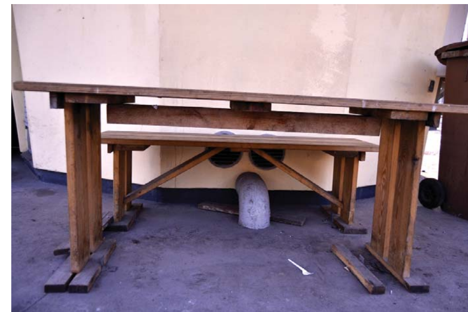
Kuva 23. Ilma-aukot ulkoseinällä ja tummaksi maalattu sokkeli.
