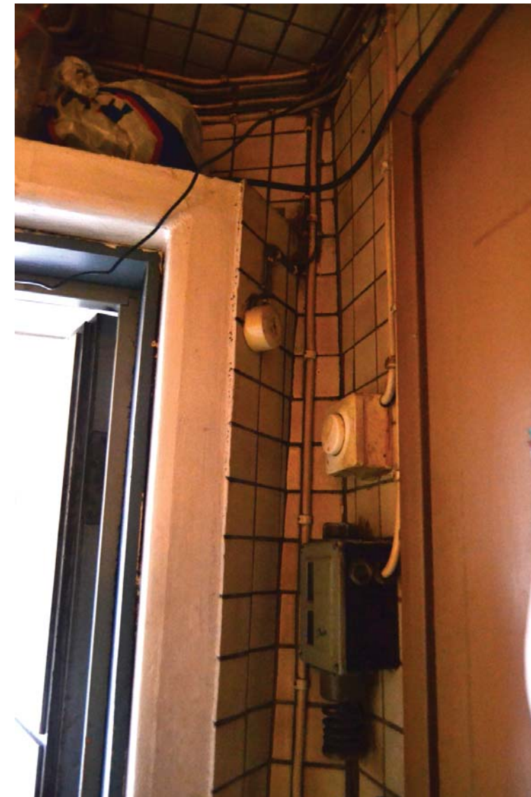
Kuva 46. Ulko-oven karmi työnny ulos kallistuvasta ulkoseinästä.
