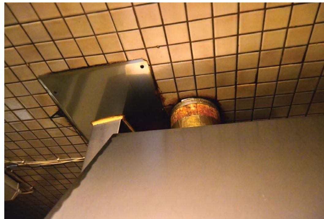
Kuva 54. Liesituulettimen läpivienti katolle.
