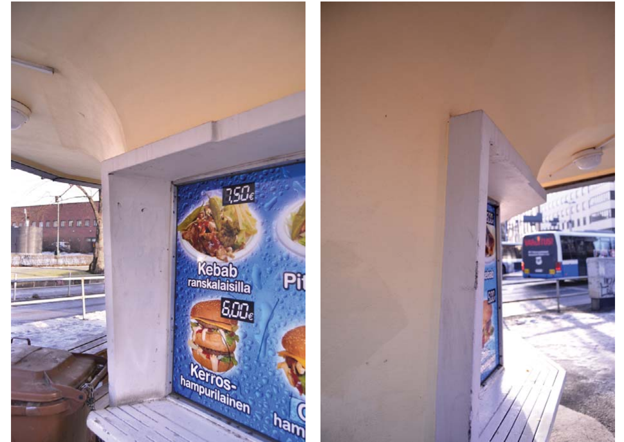
Kuva 22a ja b. Ikkuna-aukkoja on korostettu valkoiseksi maalatulla betonisella reunuksella. Ulkoseinän kallistuksesta johtuen reunuksen sisäreuna on syvämpi.
