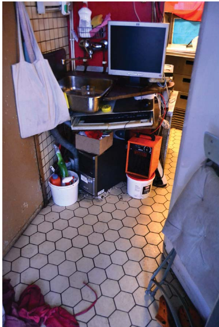
Kuva 44. Eteisen lattia ja kalusteet. Lattialistoja ei ole.
