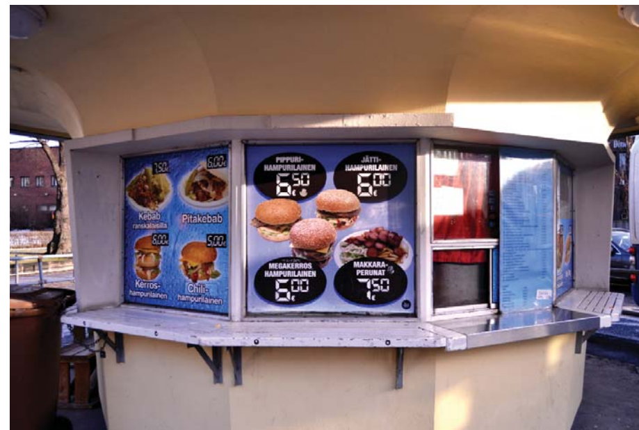
Kuva 34. Vasemmanpuoleisin ikkuna on puhkaistu rakennukseen myöhemmin. Ikkunoiden alla metallitukien päällä puinen valkoiseksi maalattu taso.
