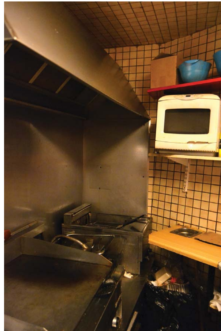
Kuva 57. RST-pintaiset paistopiste ja huuva. Kattolistoja ei ole.
