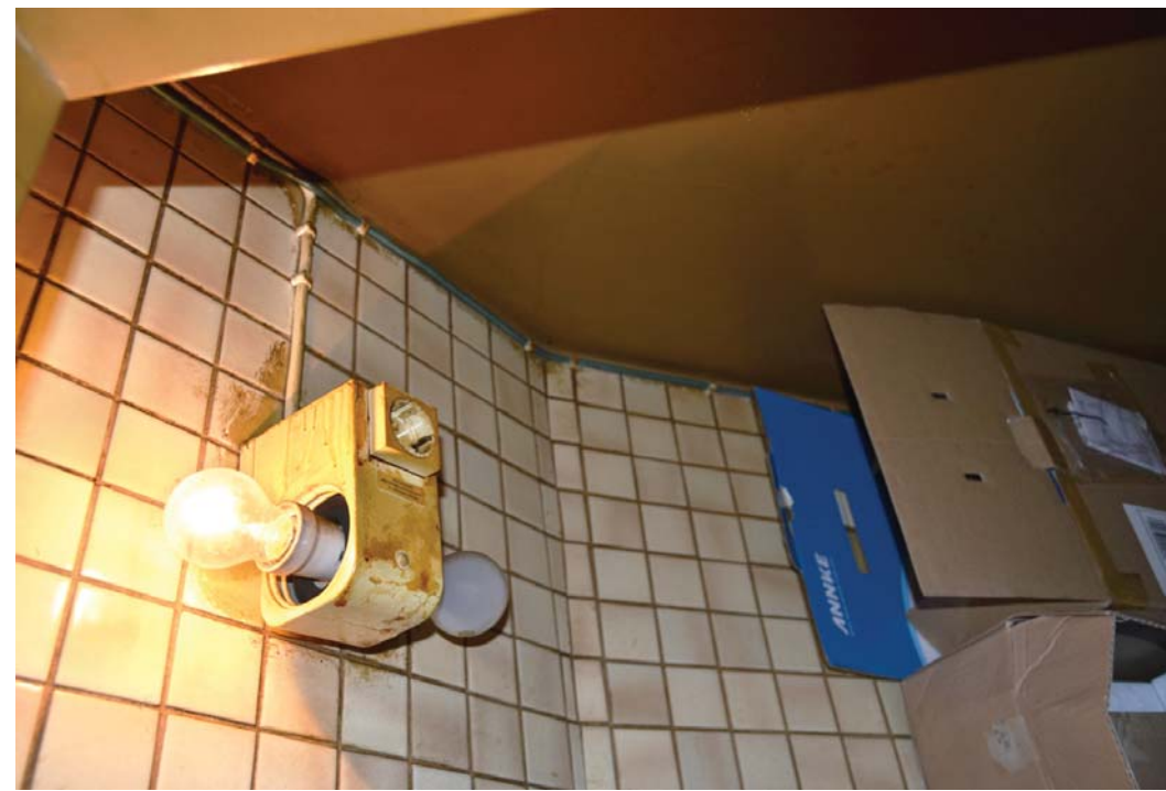
Kuva 61. Wc:n valaisin. Kattoa ei ole laatoitettu, vaan maalattu ruskeaksi.
