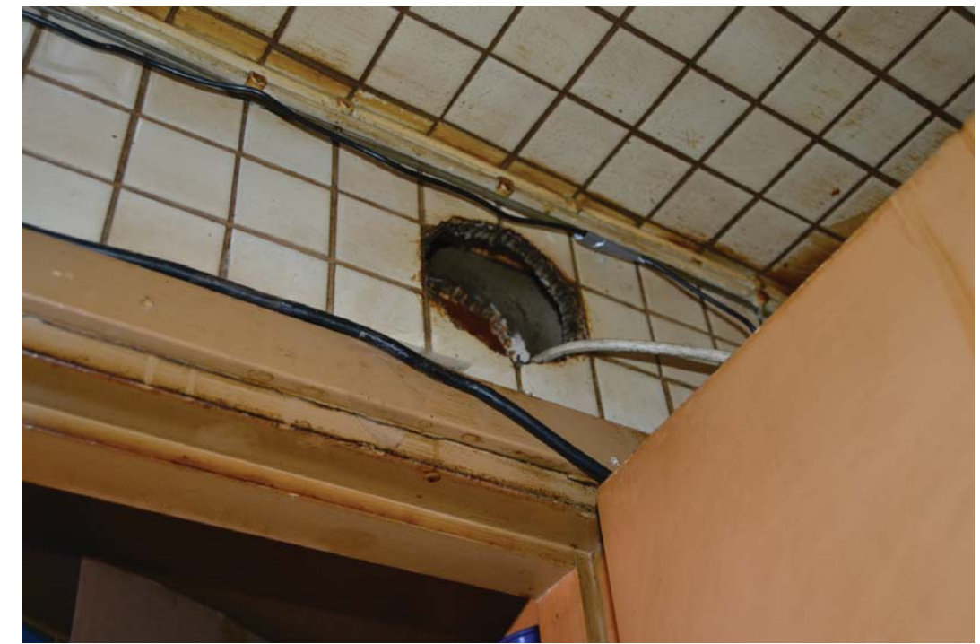
Kuva 62. Läpivienti wc:n ja eteisen välillä eteisestä kuvattuna.
