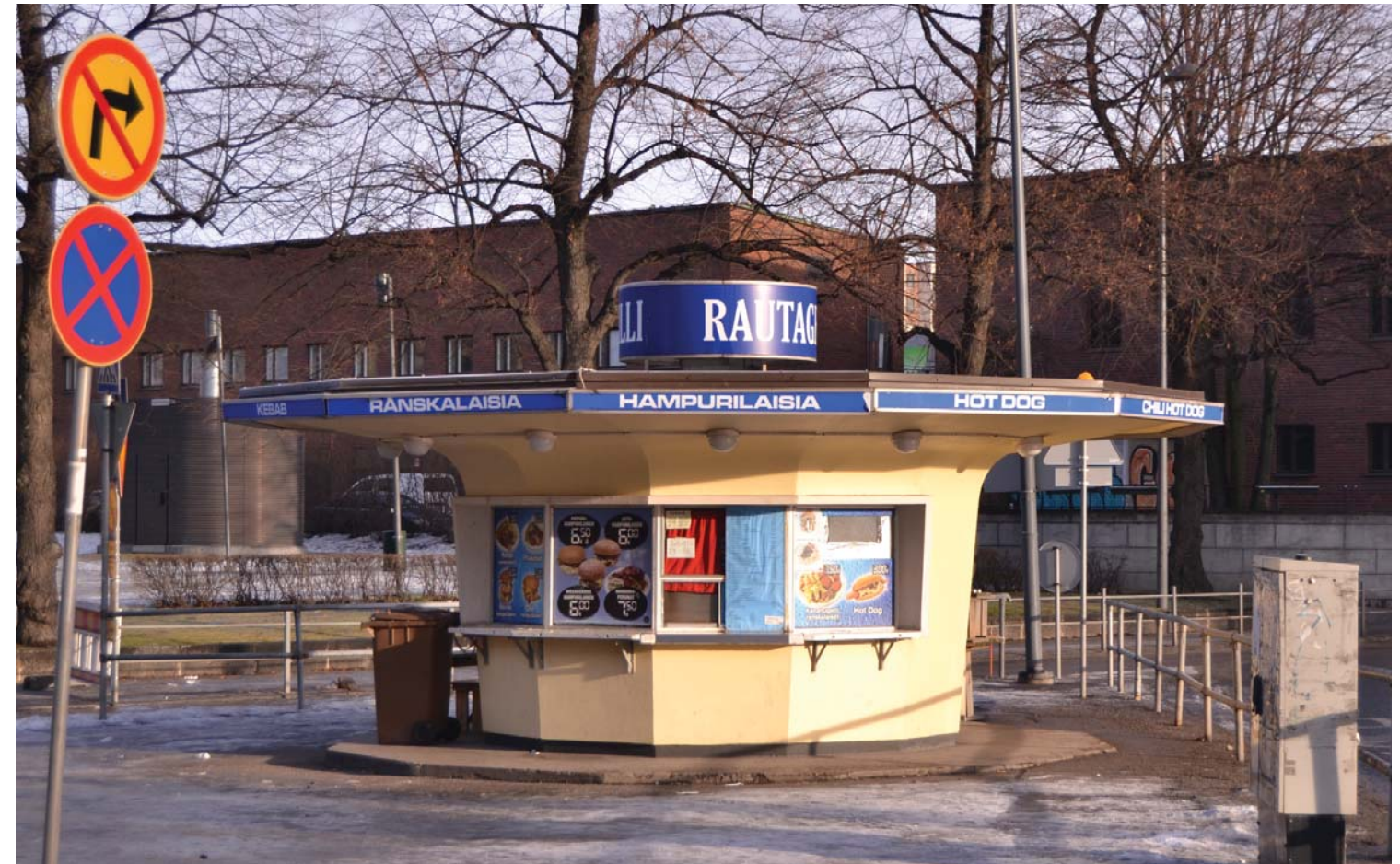
Kuva 32. Julkisivu länteen. Nauhaikkunoita peittää myyntiluukku lukuun ottamatta mainokset.
