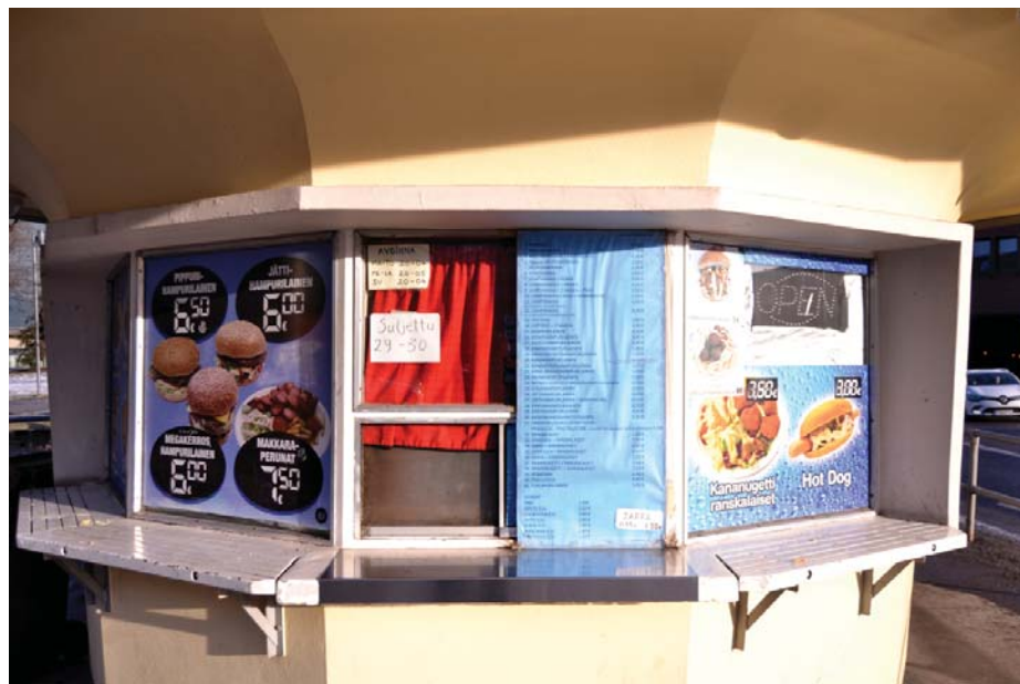
Kuva 33. Myyntiluukku ja kaksi ympärillä olevaa alkuperäistä ikkuna-aukkoa. Myyntiluukun edessä tasoa peittää suojus ruostumattomasta teräksestä. Myyntiluukku jakaa ikkunan kahteen osaan.
