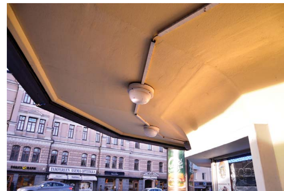
Kuva 31. Nauhaikkunoiden yllä katoksessa on yksinkertaiset valaisinkuvut.
