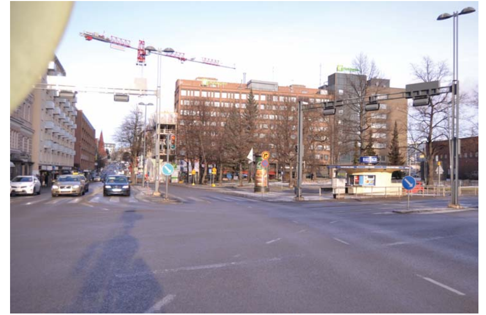
Kuva 10. Näkymä Rautatienkadun risteyksestä pohjoiseen. Taustalla Rautatienkadun ja Postitalon työmaa.
