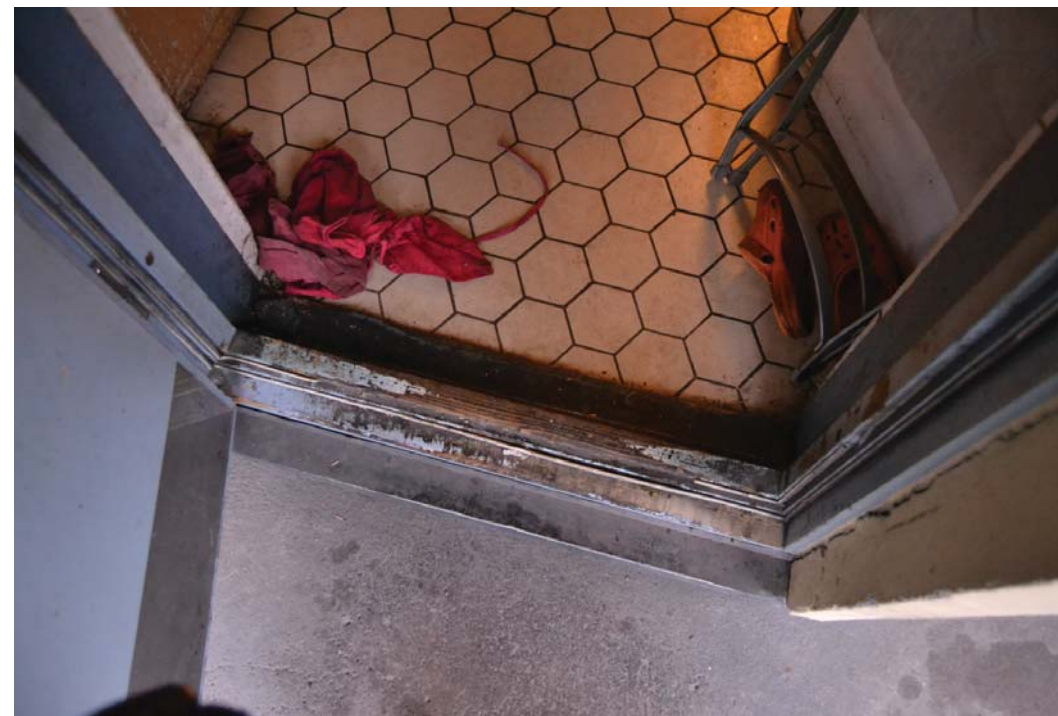
Kuva 36. Ulko-oven puinen kynnyks. Lattia on kaikkialla tilassa vaaleaa klinkkerilaattaa.
