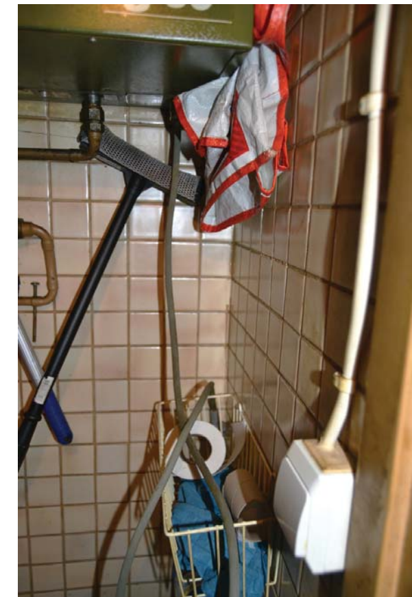
Kuva 66. Wc:n valokatkaisija on uusittu.
