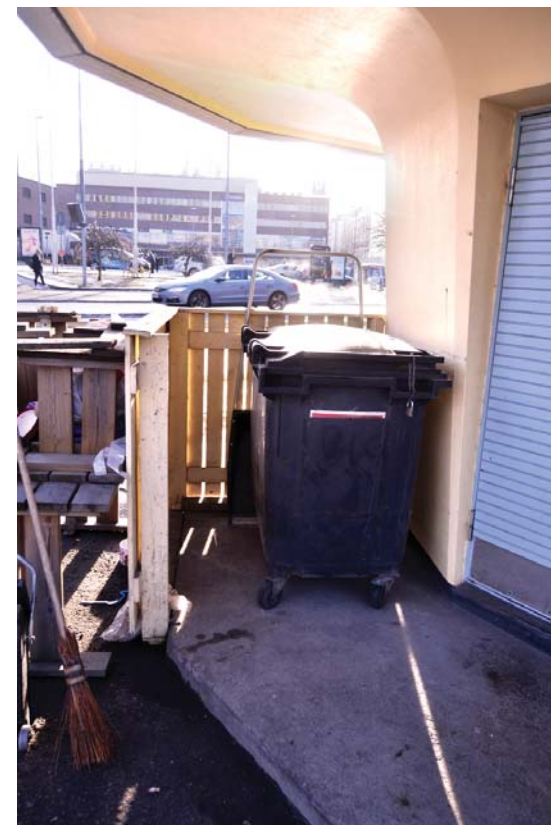
Kuva 26. Jäteastialle rakennettu matala aitaus on kevytrakenteinen.
