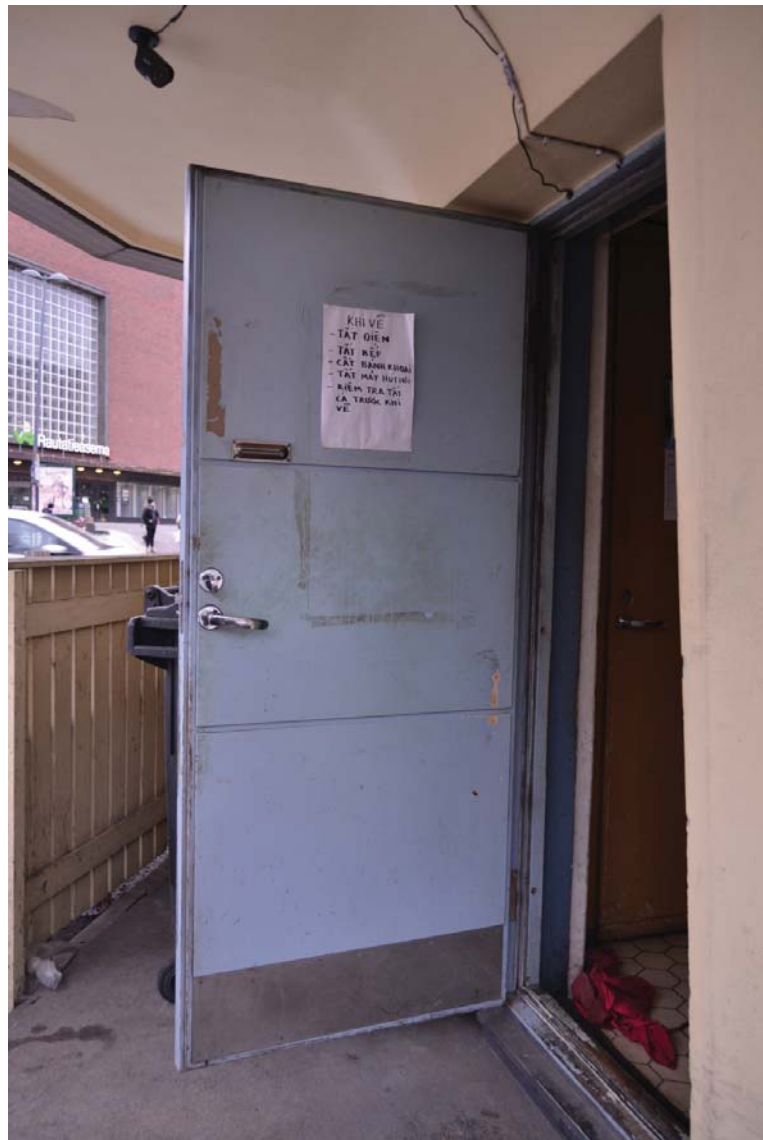
Kuva 39. Vaaleansininen puinen ulko-ovi, jonka alareunassa teräksinen potkupelti.
