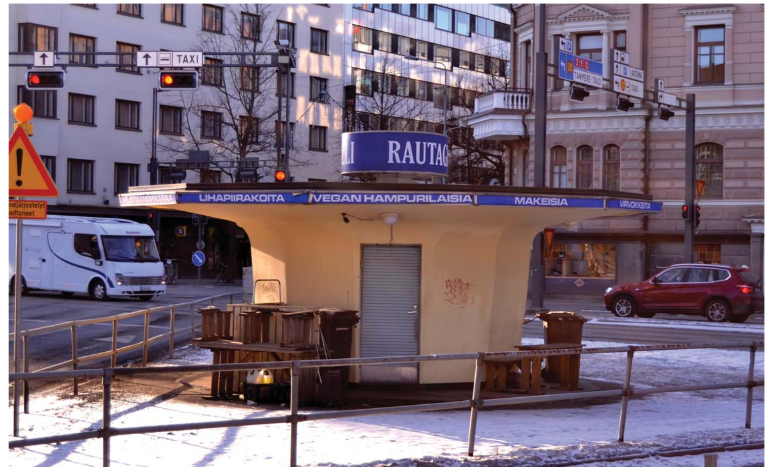
Kuva 25. Julkisivu itään. Jäteaitauksen edessä on säilytyksessä kioskin ulkokalusteita.
