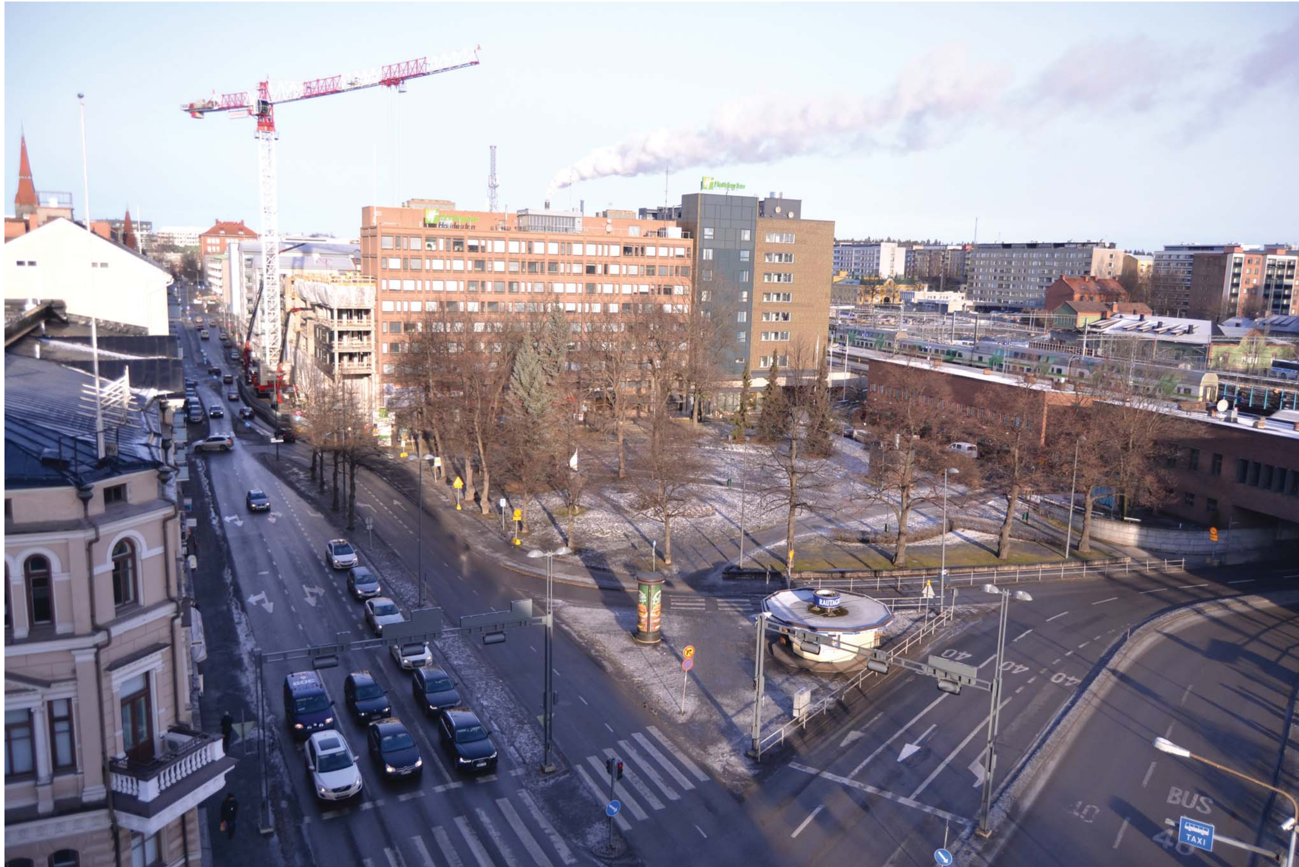
Kuva 6. Näkymä Rautatiekadun Scandic -hotellista pohjoiseen Rautatiekadun suuntaan. Taustalla näkyy Rautatiekadun ja Postitalon työmaa. Kioskirakennus sijoittuu liikenteen solmukohtaan.
