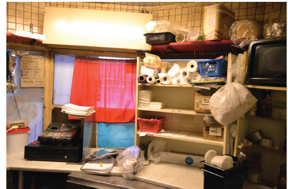
Kuva 49. Näkymä myyntiluukulle. Luukun edessä verhon alla irtonainen teräslevy. Katon rajassa vanha sähkölaite.
