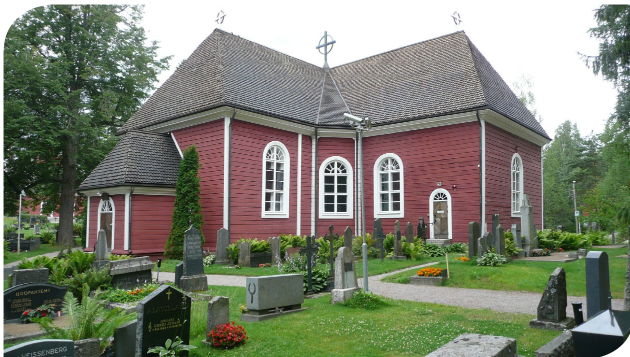
Teiskon kirkko. Kuva Rakennusvalvonnan kuva-arkisto.
