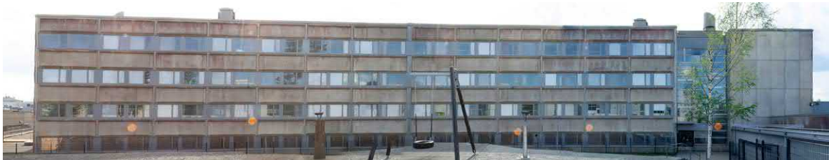
Valokuva julkisivusta itään.
