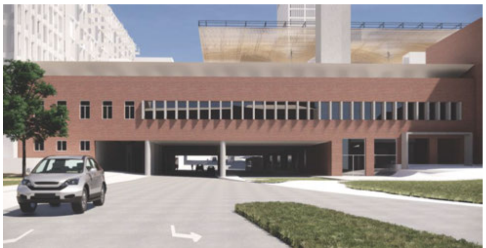
Kuva 85. Yllä Itsenäisyydenkadun tunnelin läntisen sisäänkäynnin nykytila. Alla visualisointi, jossa tunnelia on levennetty n. 5,3 metriä pohjoiseen. (Alla oleva kuva: COBE & Lunden)
