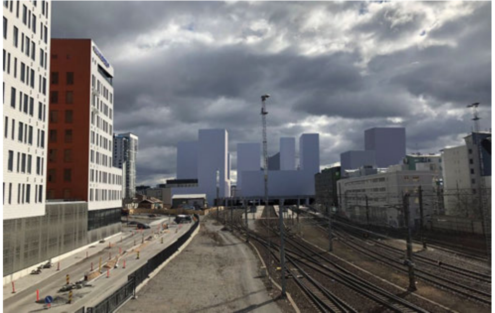
Kuva 66. Näkymäkuva Erkkilänsillalta, näkymäpiste 5. (WSP Finland)
