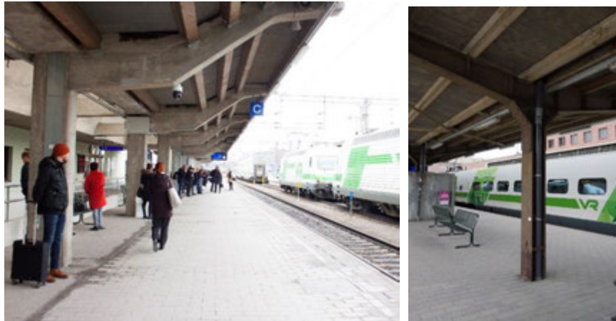
Kuva 42. Junalaiturien betoniset katosrakenteet ja niittiteräsrakenteiset välilaiturikatokset.
