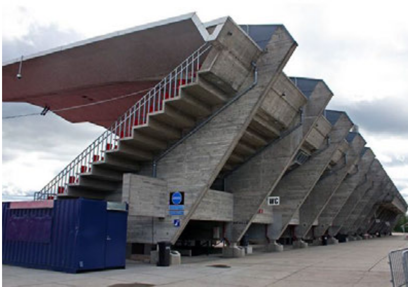
Kuva 25. Ratinan stadionin betonirakenteita. Timo-Pekka Heima, 2008, Museovirasto.
