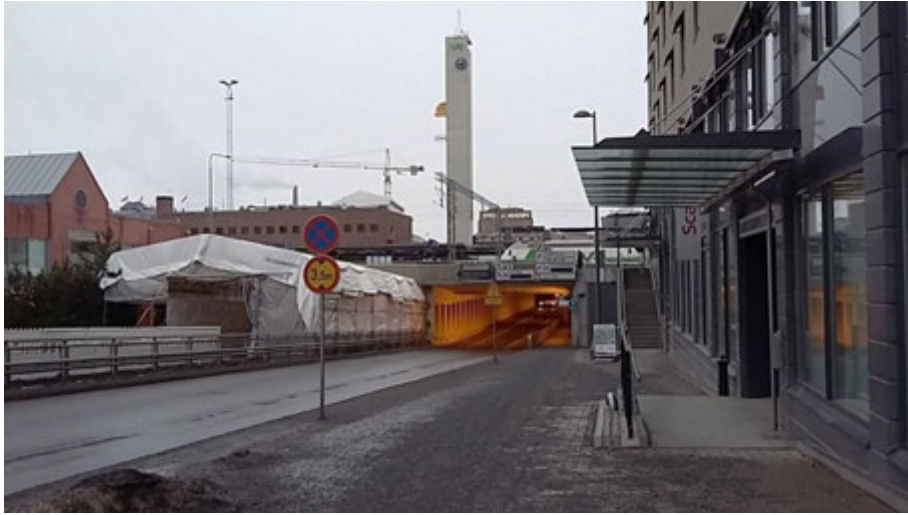
Kuva 11. Näkymä Itsenäisyydenkatua pitkin länteen kohti suunnittelualuetta. Kuvassa näkyy Itsenäisyydenkadun tunnelin nykytila. Kadun keskellä raitiotien työmaa.
