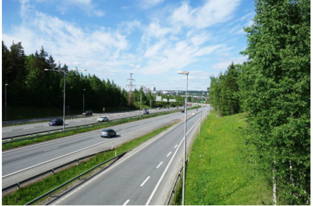
Kuva 70. Näkymäkuva Lempääläntien sillalta Yhdystie 3495:n yllä, näkymäpiste 23. (WSP Finland)
