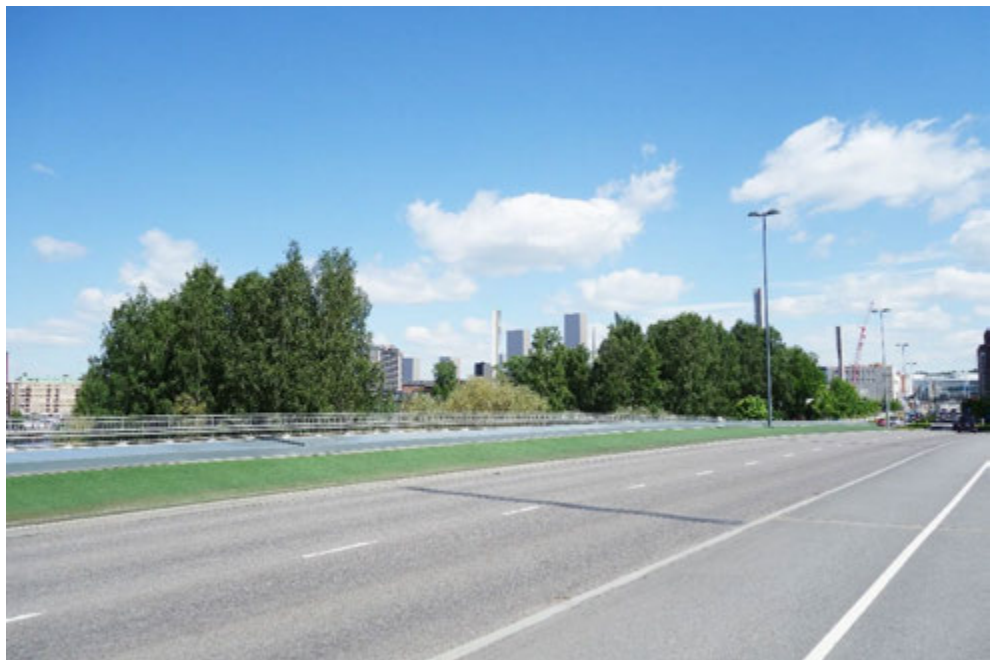
Kuva 53. Näkymäkuva Tampereen valtatie sillalta Eteläpuistosta Ratinalle, näkymäpiste 14. (WSP Finland)
