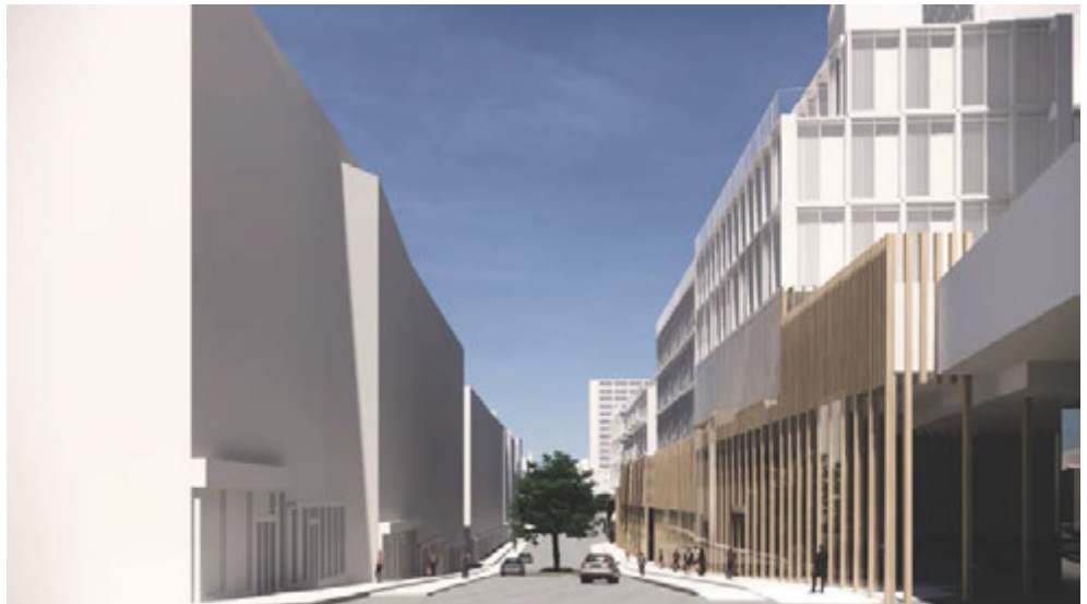
Kuva 77. Visualisointi Rautatienkadulta pohjoiseen Suvantokadun kohdalta. (Kuva ylhäällä: Google Maps, Kuva alhaalla: COBE & Lunden)
