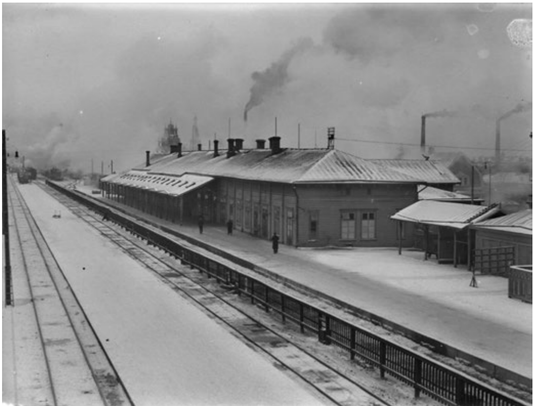
Kuva 24. Tampereen vanha puinen 1876 valmistunut rautatieasema juuri ennen purkamistaan marraskuun lopussa 1933. (Tampereen museoiden kuva-arkisto)
