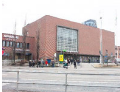
Osoite: Rautatienkatu 25 Rakennusvuosi: 1936 Omistaja: VR-yhtymä Oy Suunnittelu: Otto Flodin ja Eero Seppälä 1934, Eero Seppälä 1937, Jarl Ungern 1947, Erkki Karvala 1988
