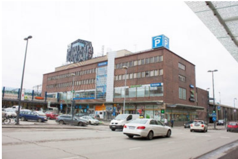
Kuva 31. Rautatienkatu 27 rakennuksen pohjoissivu.
