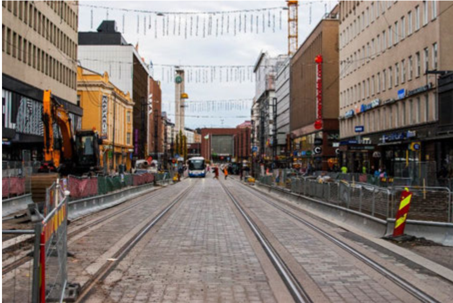
Kuva 6. Rautatieasema Hämeenkadun päätteessä. Kuvissa näkyvä raitiotien työmaa-alue Hämeenkadun osuudella valmistuu 2019 loppuun mennessä.
