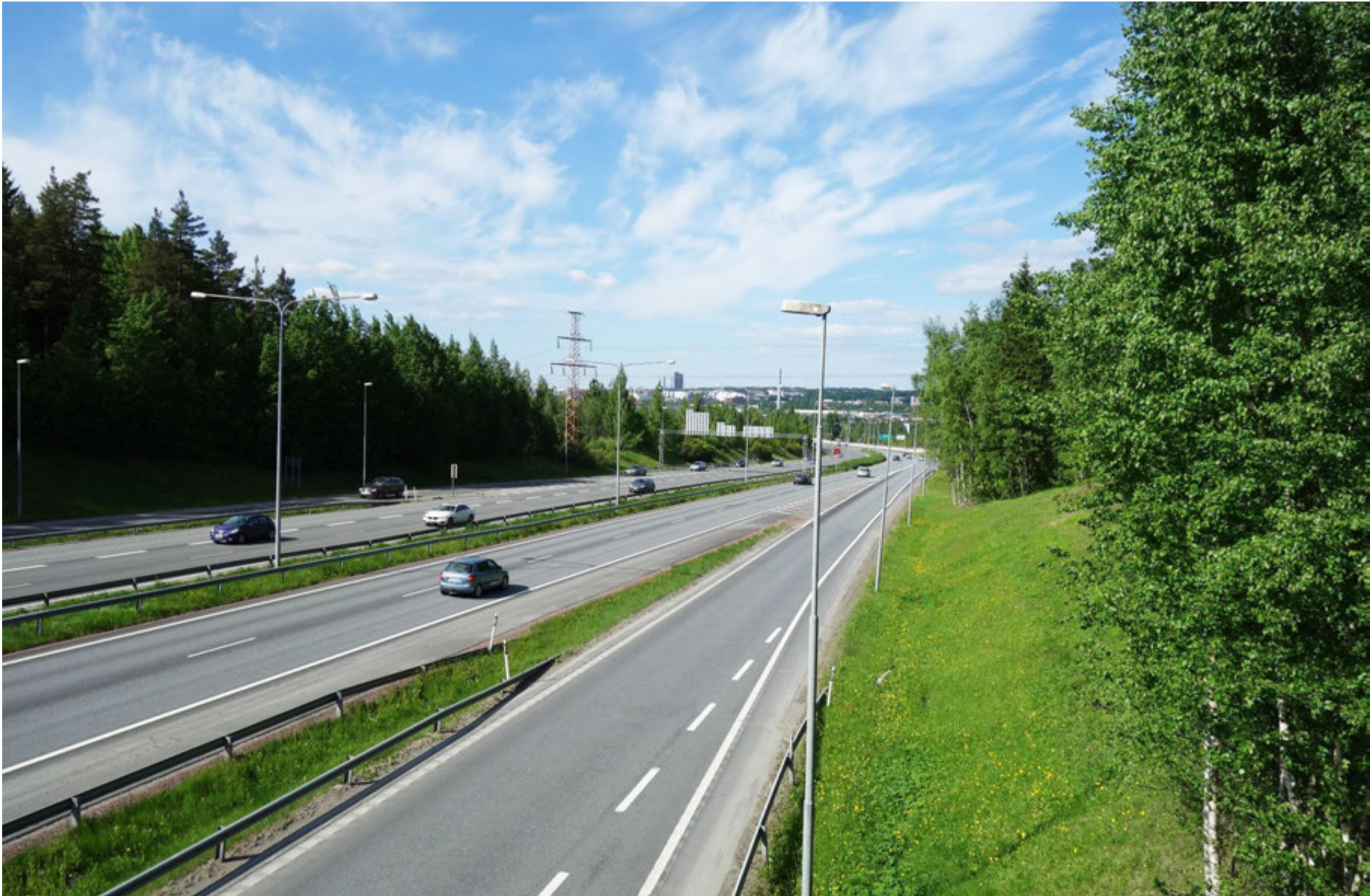
NYKY. Näkymäpiste 23. Lempääläntie silta
