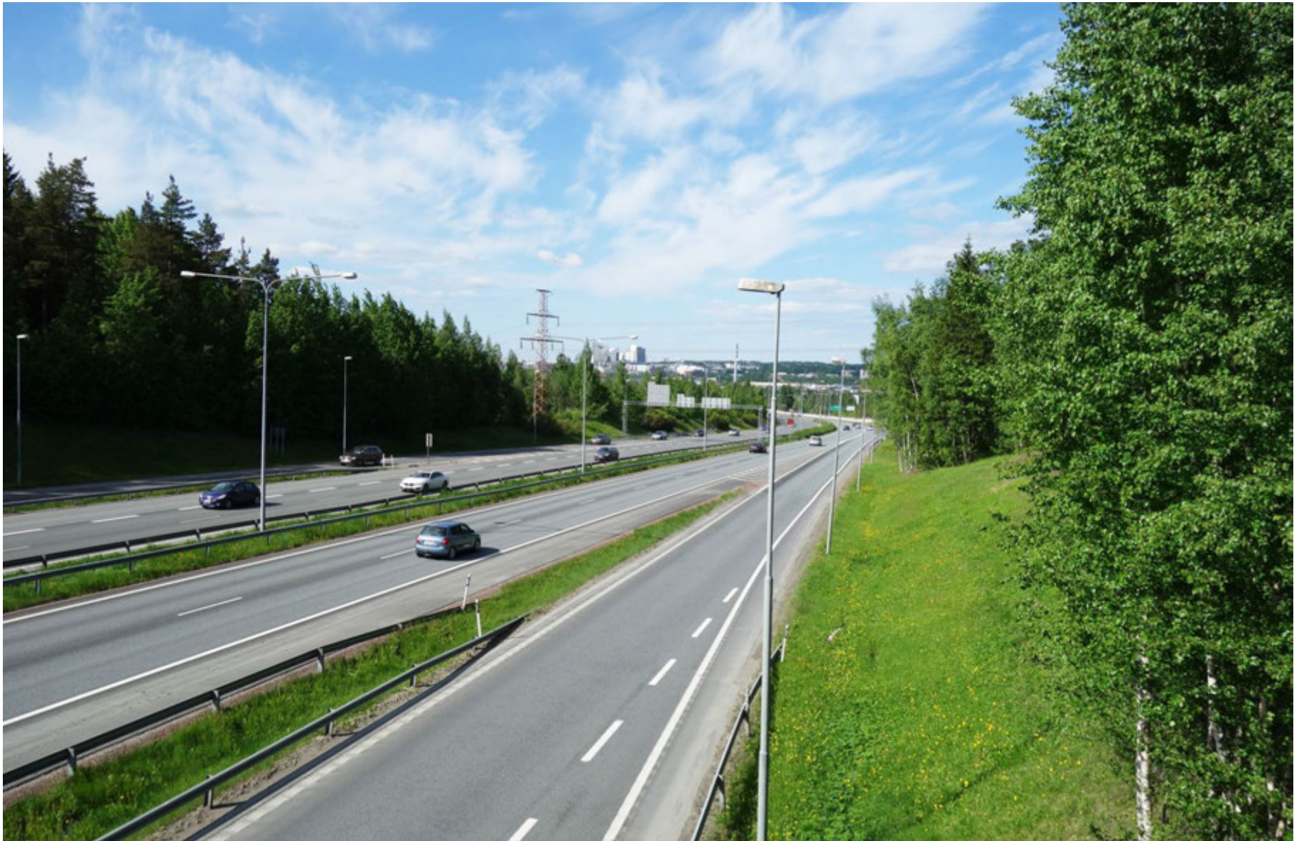
YS 2019. Näkymäpiste 23. Lempääläntie silta
