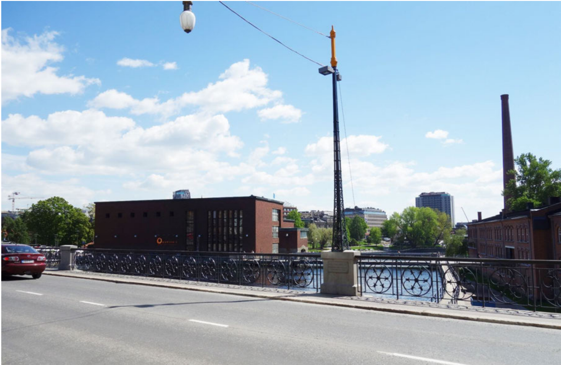
NYKY. Näkymäpiste 6. Satakunnansilta
