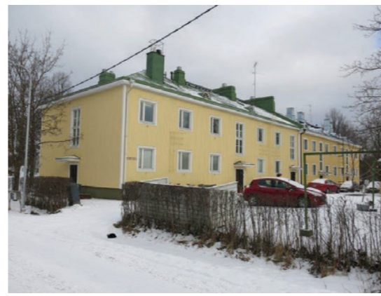
1930-luvun lopun puukerrostalossa Erätiellä on nähtävissä joitain 1920–30-lukujen puuklassismin piirteitä, kuten julkisivujen symmetria, aumakatto ja ullakon lunetti-ikkunat.
