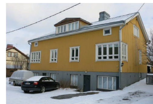
1936–37 rakennetussa paritalossa Erätiellä on orastavan modernismin piirteitä, kuten kulmaan sijoitetut ikkunat ja räystästä alas asti yhtäjaksoinen julkisivulaudoitus.
