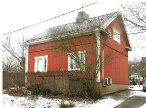
Puolitoistakerroksinen yhden perheen talo Ahotiellä.
