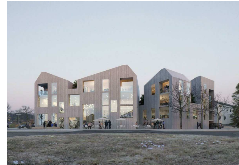
KUVA 2 Rakennusten ylimmät kerrokset on rikottu harjan muodolla. Ylimmissä kerroksissa 2-tasoisia asuntoja
