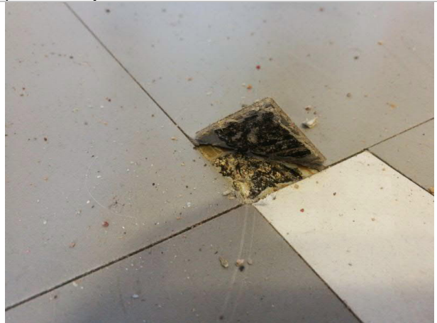
pistokoetarkastus C210 pikiliimaa lattian pinnoitteen alla
