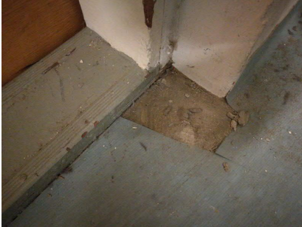
Näyte 7. lattian muovimatto, liima ja tasoite → ei asbestia
