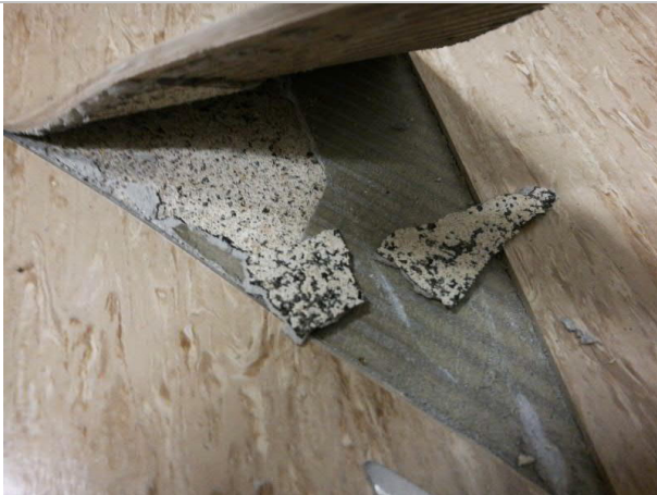
pistokoetarkastus C128B, pikiliimaa lattian pinnoitteen alla
