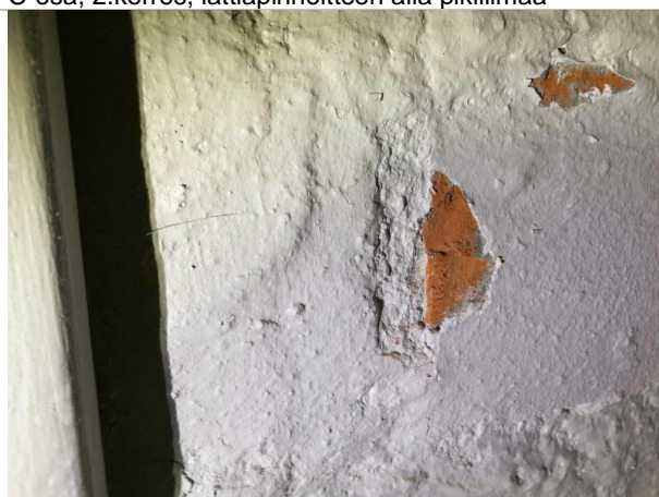
Näyte 6. seinän tasoitteista → ei asbestia
