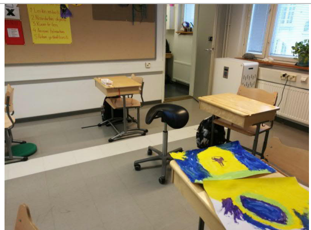
A206 yleiskuva, pääasiassa luokissa kuvaa vastaava muovilaattapinnoite, A-osassa ei havaittu asbestipitoista liimaa alla
