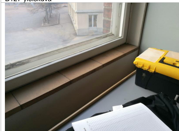
Näyte 5. ikkunalaudan laatoituksesta ja laasteista → ei asbestia
