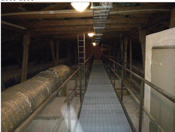
A-osa yläpohja, näyte 3 vesikaton bitumihuovasta (vanha pinnoite)
