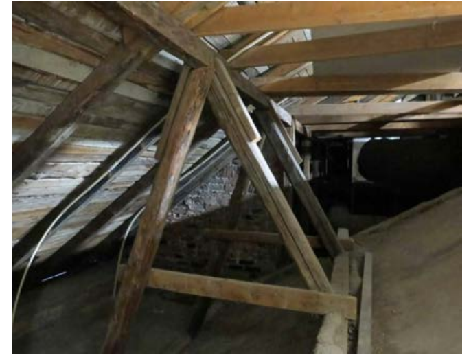
Kattotuoleja ja -vasoja rakennuksen sivulla.
