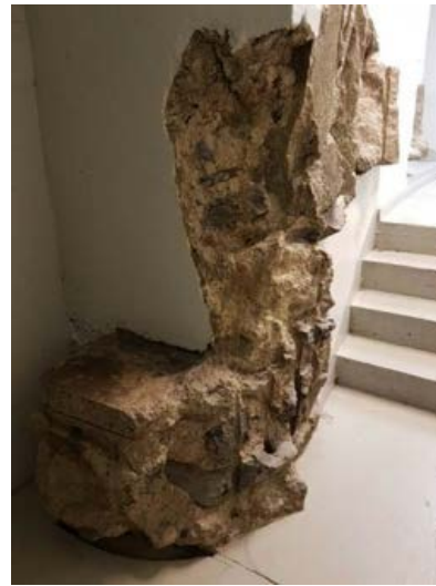
Kellarin laajennuksessa esiintulleita perustuksia.
