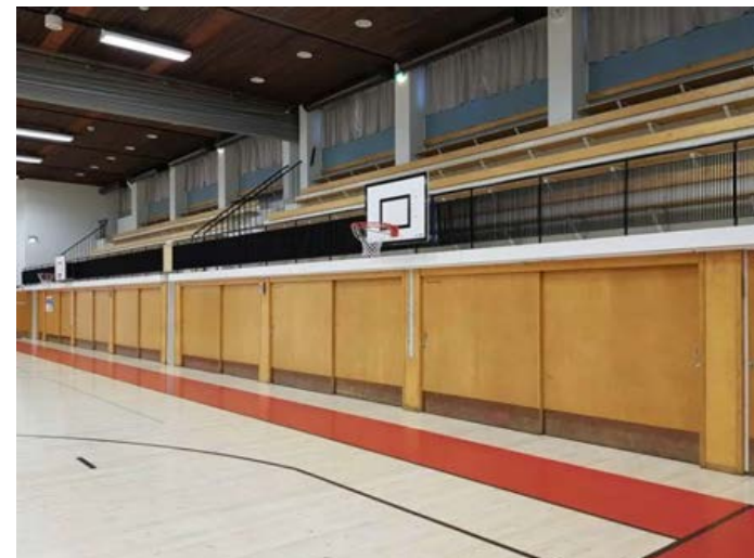
Liikuntaväline varasto ja veto-ovet potkulevyineen (messinki).
