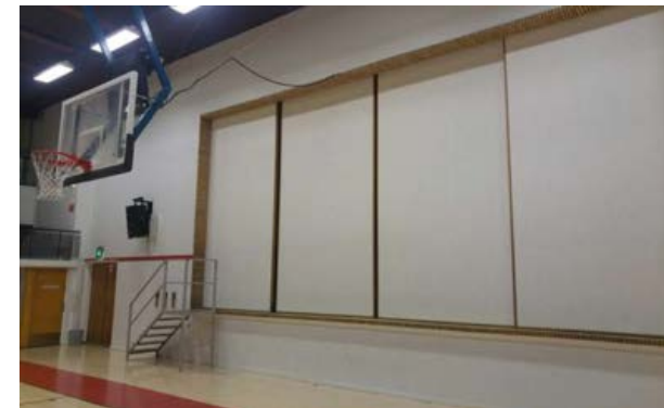
Liikuntaväline varasto ja veto-ovet potkulevyineen (messinki).
