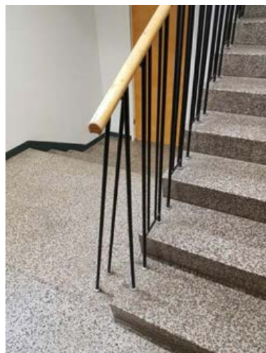
Pyöröteräksinen pinnakaide ja pulset käsijohteet pohjakerroksen rapuissa .
