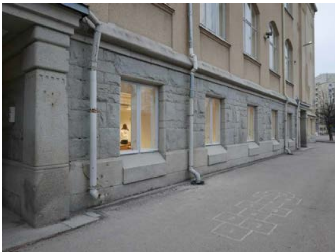
Lounaisfasadi pohjakerroksen rustiikkia lohkokivestä. Ja sisäänkäynti pylväineen.
