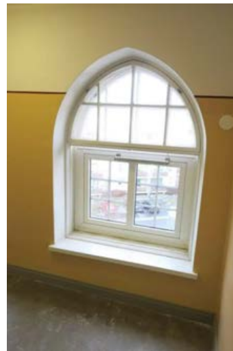
Välitasanteen (3-4 krs) ikkuna koillissivulla.
