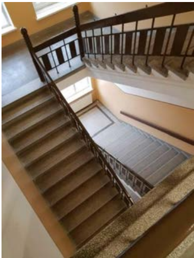
Porrashalli, kaide ja syöksy ullakolta alaspäin.
