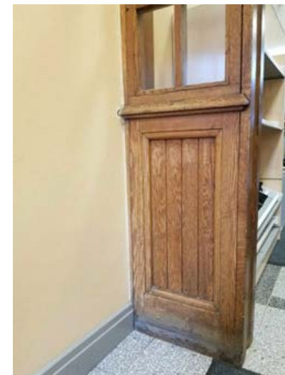
Pohjakerroksen tuulikaapin ovi listoineen.
