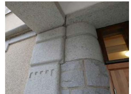
Sisäänkäynnin (oik.) graniittidetalleja ja vesikerroslistan kulmaprofiili.
