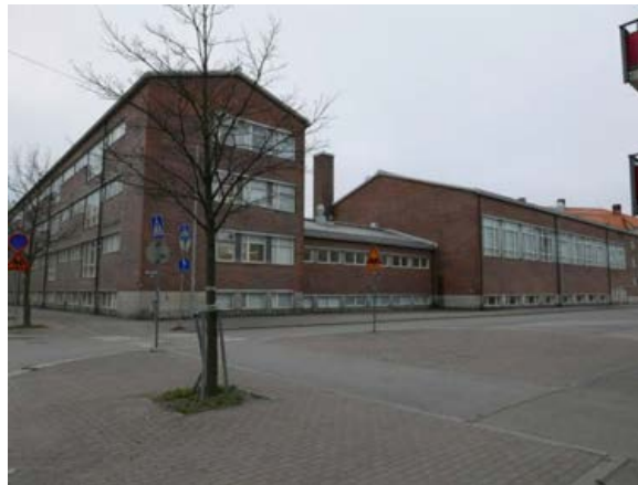
Pohjoissivu (luokkasiiven pääty) Väinöläkadulta.
