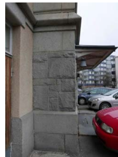
Kaakkoisfasadi kerros- ja vesilista sekä sisäänkäynnin lippa.
