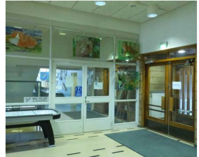
Kolmas pääovista erotettu väliseinällä (palo-ovi) yhteydestään.
