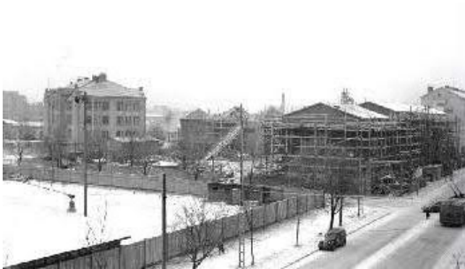
Lisärakennus rakenteilla 7.5.1957. (M. Laitinen TM)
