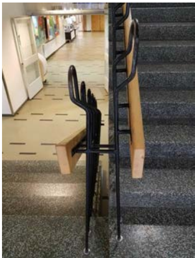
Pyöröteräksinen pinnakaide ja pulset käsijohteet pohjakerroksen rapuissa .
