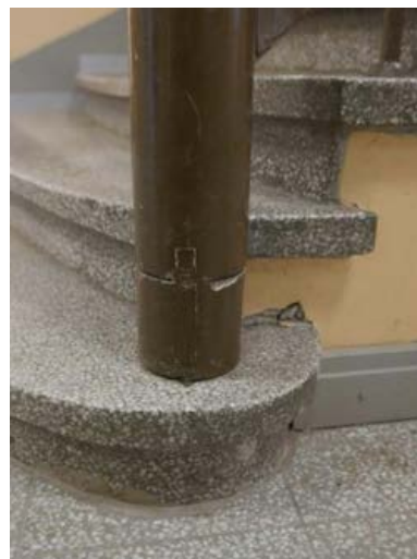
Pohjakerros, sementtimosaiikki rappulaatat, viimeistely muoto.
