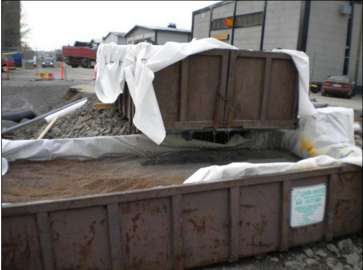
Kuva 6. Esimerkkikuva vaihtolavan sisään rakennetusta suodattimesta. 4
