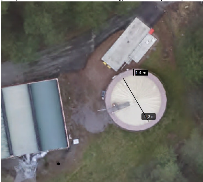
Kuva 3. Hakametsän lämpökeskuksen kevytöljysäiliö ja säiliön täyttöalue.
