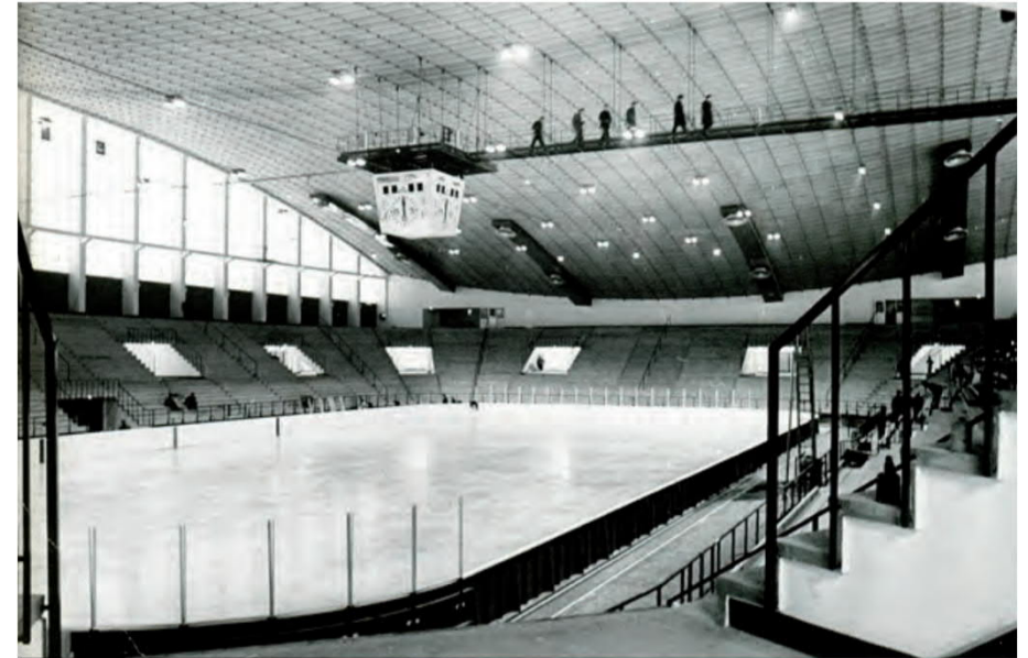
Hallin päätila lopputarkastuksen aikaan vuonna 1965. Tarkastajat kulkevat kellosoillalla 18 metrin korkeudessa. Kuva: Hirvikallio, 2015; Leinonen, 2015
