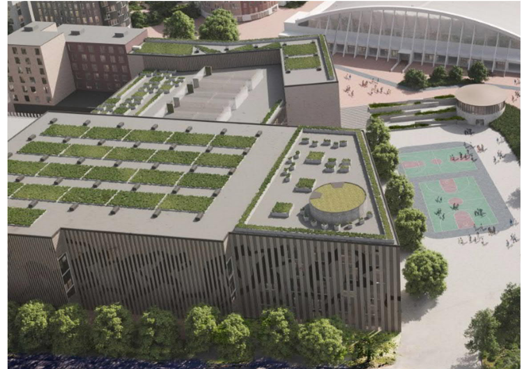
Hybridikorttelin erilaisia konteksteja; jalankulkuvaltaiset aukiotilat ja toisaalta suurpiirteisempi mittakaava Hervannan valtavyhlällä. Kuva: Arkkitehdit Kontukoski Oy, Arkkitehtitoimisto Ahonen ja Kangasvieri Oy, Heikkinen & Kangasaho Arkkitehdit Oy
