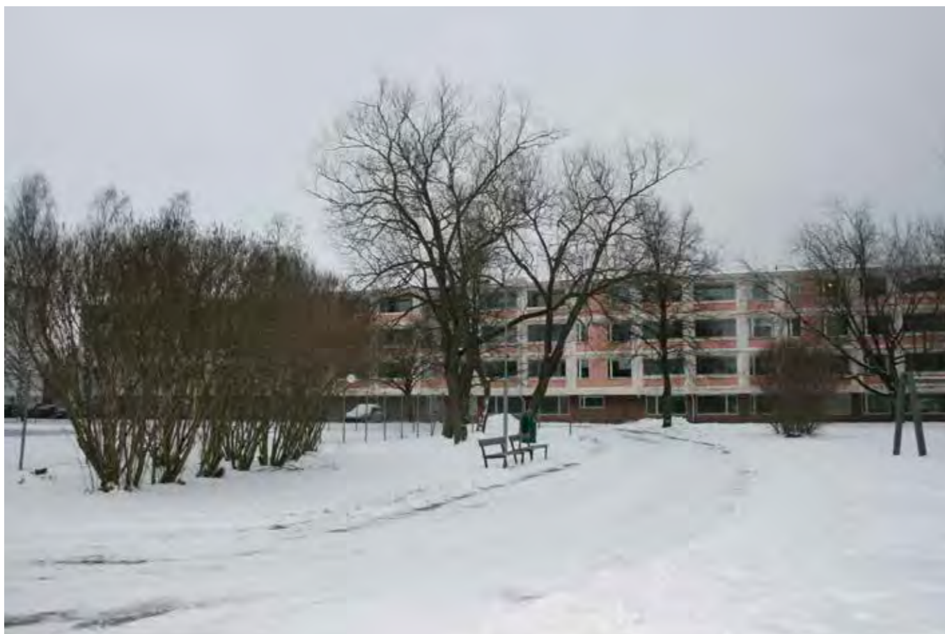
Kuva 39. Keltinkatu 4-6 Uudenmaanpuiston suunnasta kuvattuna.
