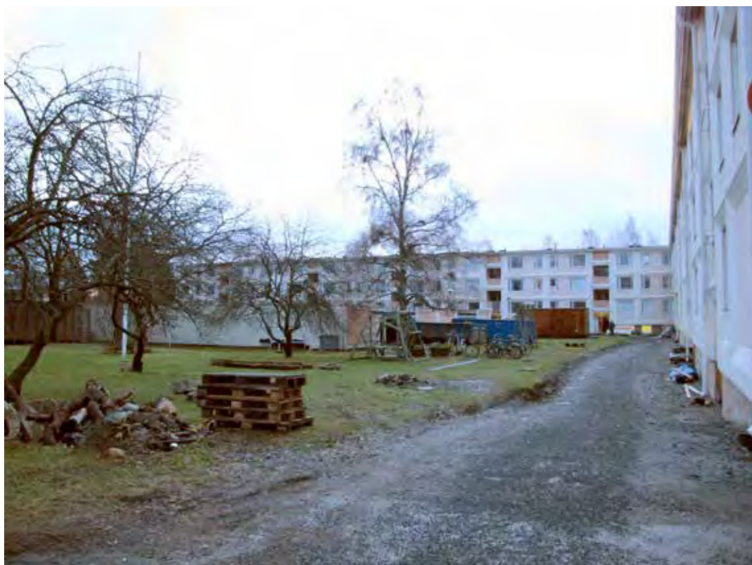
Kuva 113. Keltinkatu 4-6 sisäpiha. Kiinteistössä on meneillään remontti.
