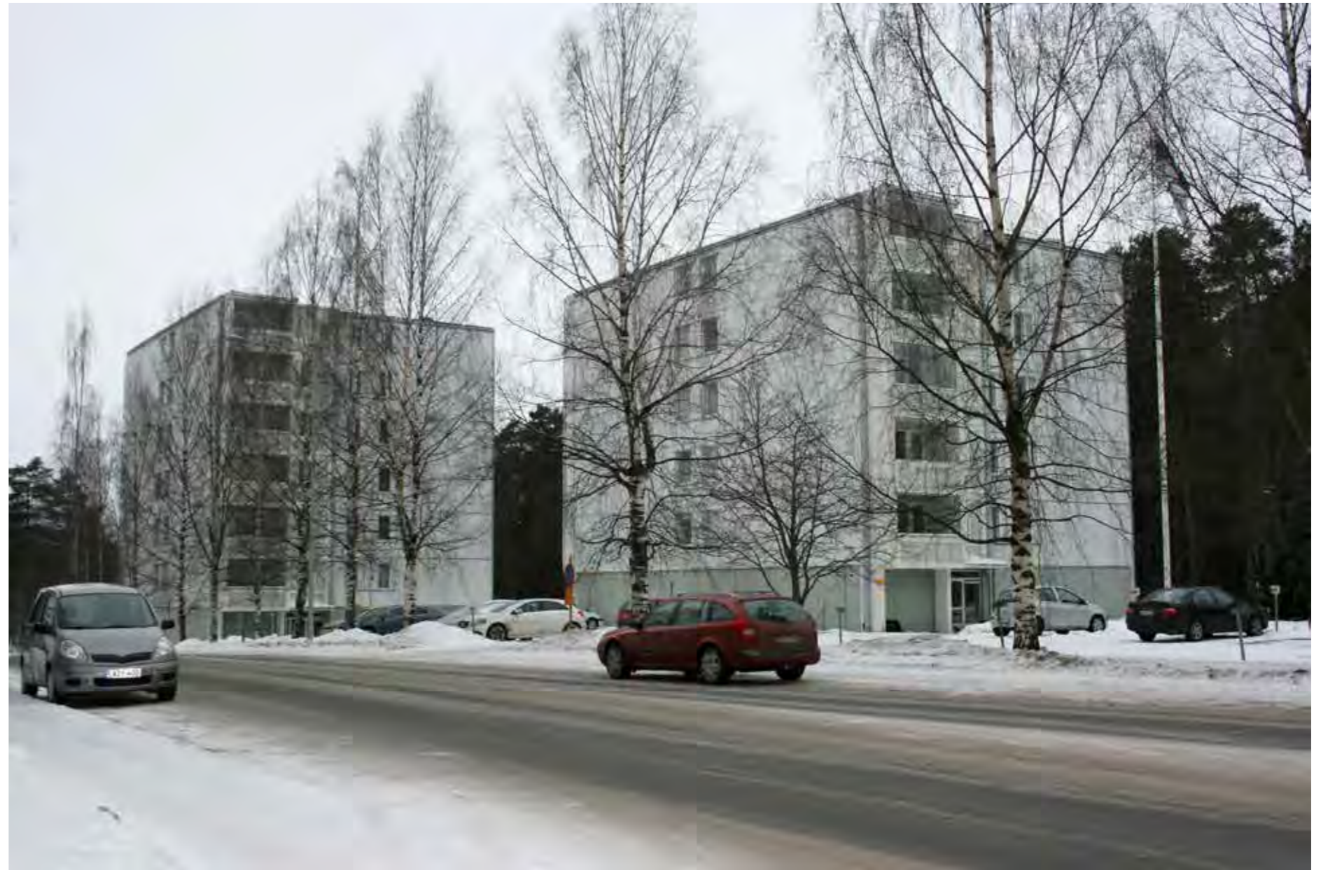
Kuva 37. Uudenkylänkatu 3:ssa sijaitsevat AUSA-elementtikerrostalot.
