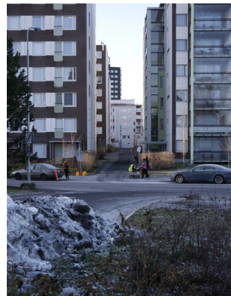
Tutkijankadun ja Hepolamminkadun välinen kortteli Tietoraitilta länteen
