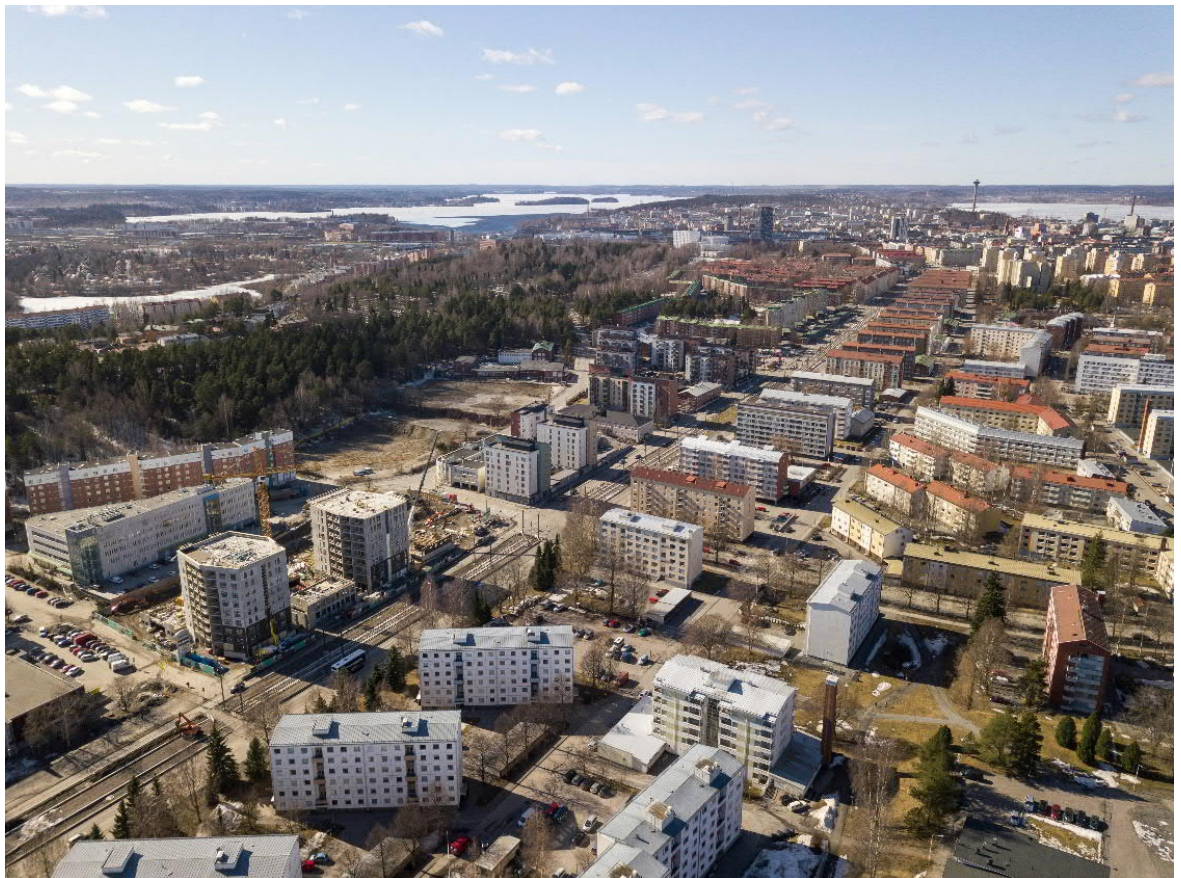
Alueen tonttien valmistelu ja rakennuskannan purkaminen on aloitettu 2018-19. Dronekuva 2019.
