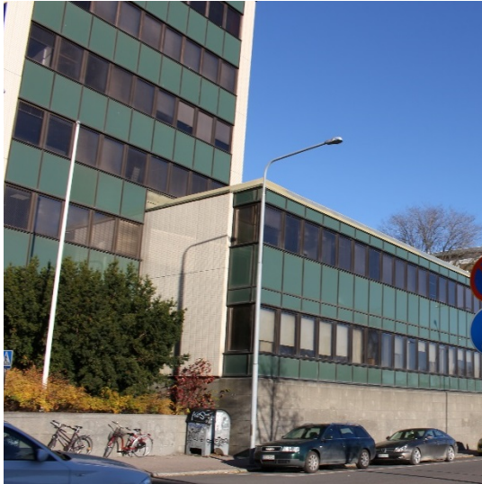
Toimistorakennuksen eteläjulkisivua. (kuva: Tampereen kaupunki)
