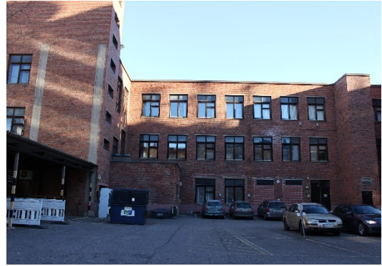
Letkutehtaan itäjulkisivua. (kuva: Tampereen kaupunki)
