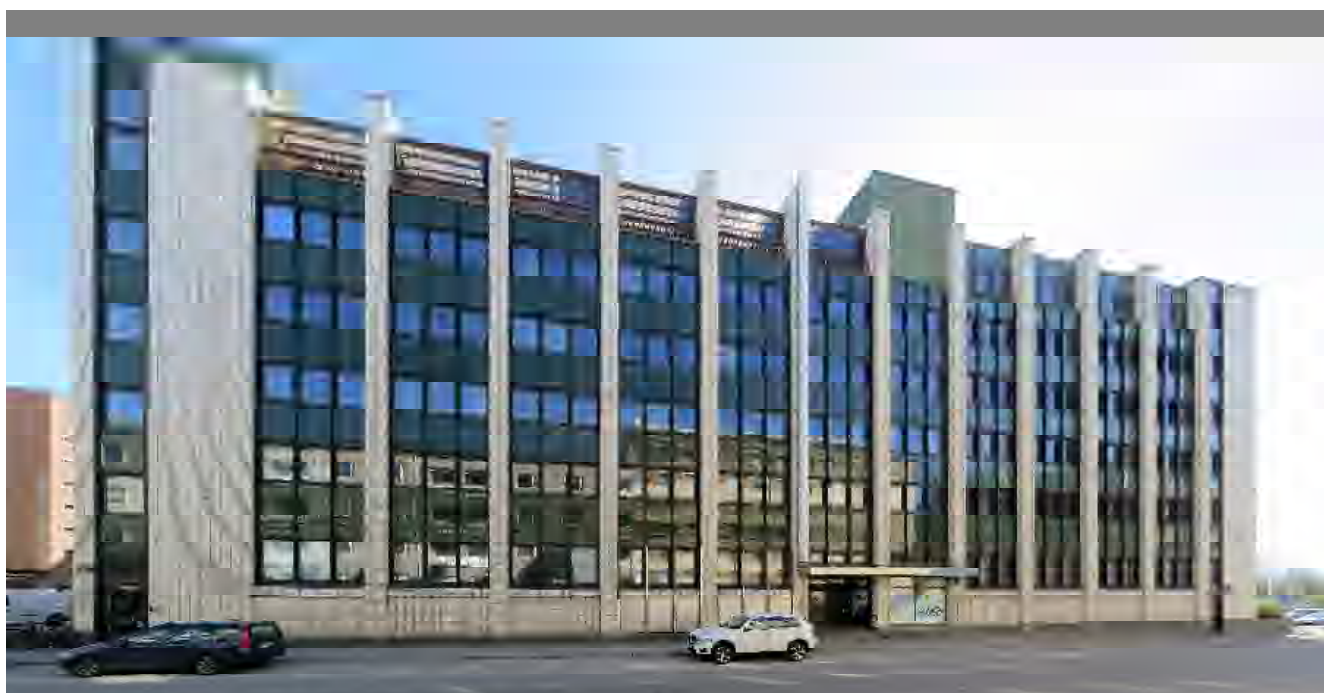
Näsilinnankadun puoleinen julkisivu on rytmitetty pystysuuntaisilla betonilamelleilla.
