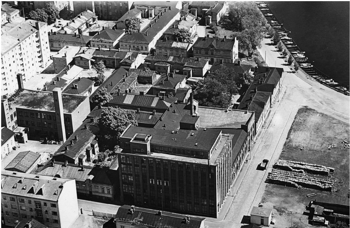
Ilmakuva vuodelta 1957. Letkutehdas sijaitsee kuvan vasemmassa reunassa. Etualalla sijaitseva tehdasrakennus ja puutalot on purettu TPO:n toimistotalon tieltä. Vapriikin kuva-arkisto.
