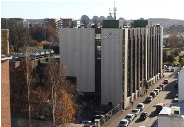
Tampereen Puhelinosuuskunnan toimistorakennus (Näsilinnankatu 41/Tiiliruukinkatu 6)
