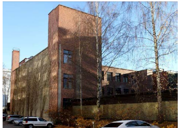
Letkutehtaan (Näsilinnankatu 39) pohjoisjulkisivu.
