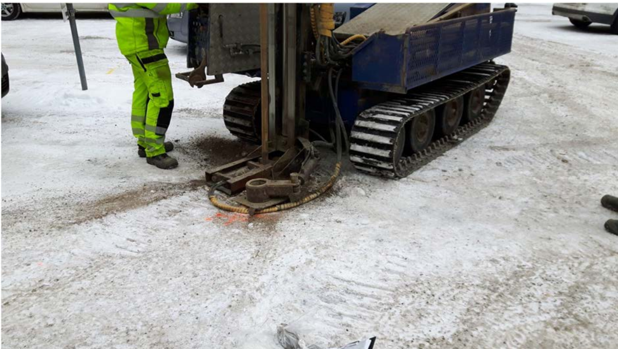
Kuva 10. Näytteen otto keskiraskaalla kairakoneella kierrekairalla.
