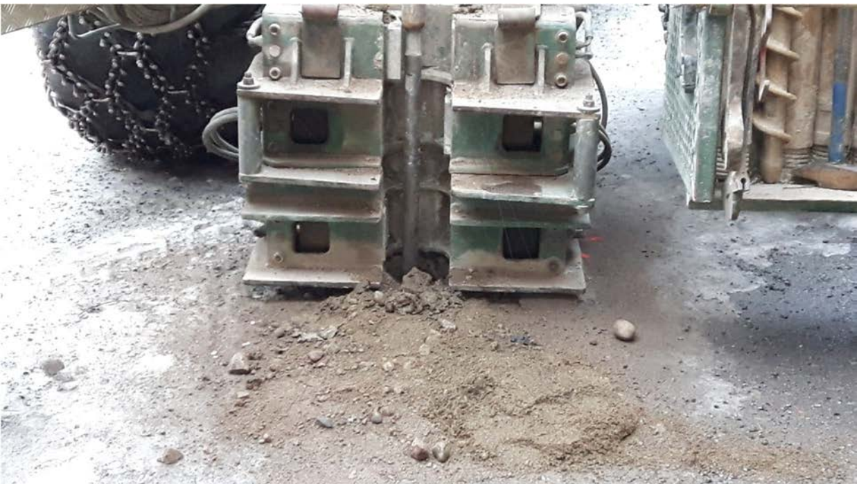
Kuva 12. Näytteenottoa raskaan kairakoneen putkinäytteenottomella.
