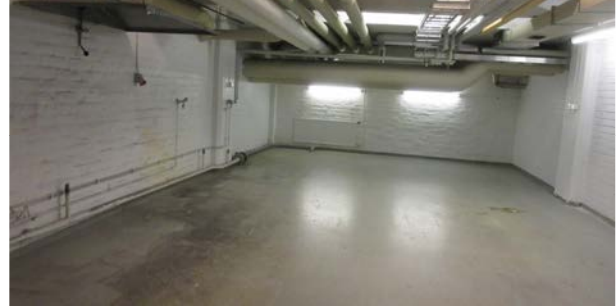
Asbestinäyte 004 ja betoninäyte 003. HUOM! Kyseinen vaaleanharmaa vinyylilaatta sisältää asbestia.
