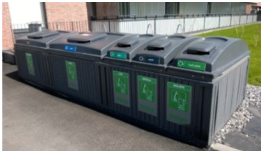
Syväkeräyssäiliöiden avulla voidaan minimoida jätehuollon tilantarve. Eri toimintoja voidaan rajata esim. pensaiden avulla visuaalisesti toisistaan. Kuva Tampereen kaupunki 2020.
