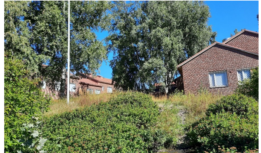
Kalevan lastentalon tiilijulkisivut Köysimäellä. Kuva Tampereen kaupunki 2022.
