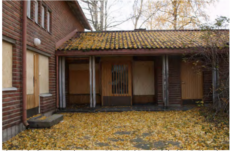
Ilmarinkadunpuolen katettu pääsisäänkäynti yhdyskäytäväkatoksen itäpuolella. Oikealla ovi entiseen lastenvaunuvarastoon ja vasemmalla ovi porrashuoneeseen.
