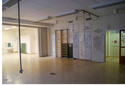
3. Saukonpuiston puolen liikuntasalissa on alkuperäiset ovet, komerot ja puolapuut. Alkuperäinen siirtoseinä on korvattu paljeovilla, mutta tilajako on säilynyt. Pinnat on uusittu ja sotkettu.
