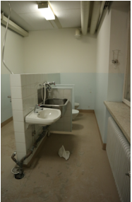
8. Ilmarinkadun 1. kerroksen wc
