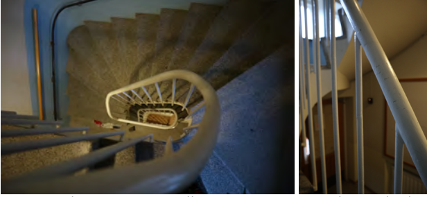
5. Porrashuoneissa on alkuperäiset pinnat. Ilmarinkadun porraskaidetta on korotettu, mutta korotusta ei huomaa ellei erikseen etsi saumojen jälkiä.
