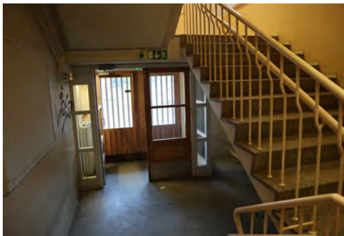
8. Puiston puolen porrashuoneiden yhteyteen on rakennettu tuulikaapit.
