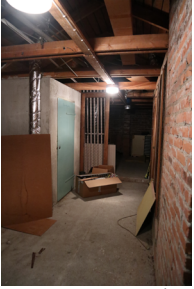
1. Puiston puolen ullakolla ei ole tehty muutoksia pintoihin.
