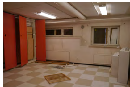
11. Neljästä pienestä huoneesta muokattu ryhmä-/päiväunihuone Ilmarinkadun kellarissa. Vanhojen seinien paikat ovat luettavissa seinistä ja ikkunoista.
