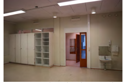
7. Puiston puolen ryhmähuone, 1. krs. Alkuperäiset ovet, komerot ja ikkunat komeroiden päällä ovat säilyneet.
