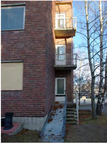
Sisäänkäynti itäisen Saukonpuiston puolen itäpäädyyn on avattu vasta vuonna 1990. Ovi poikkeaa muista ulko-ovista, koska paikalla on aiemmin ollut parveke ja vanha ovi on säilytetty.
