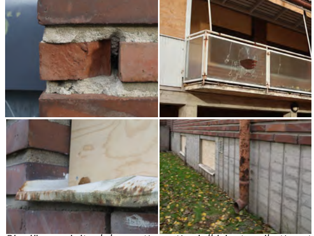
Pieniä vaurioita lukuunottamatta julkisivut vaikuttavat pääosin hyväkuntoisilta.
