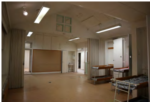
7. Ilmarinkadun ryhmähuoneissa on tehty uusia tilajakoja paljeovilla ja seinälinjojen muutoksilla. Isot ryhmähuoneet ovat kuitenkin muutoksista huolimatta säilyttäneet luonteensa ja erityispiirteensä.
