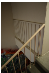
1. Varasto puiston puolen porrashuoneessa
