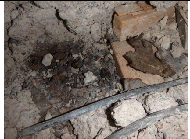
Rakenneavaus VP4. Palkin päällä eksapandoitua korkkia.
