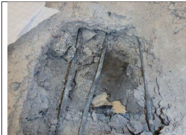
Rakenneavaus VP8. Pintalaatan alla tervapaperi ja puukuitulevy.
