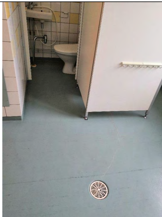
Kuva 12. tilasta 202, jonka lattiasta mitattiin kohonneita pintakosteuslukemia ja jossa havaittiin wc-istuimen vuotaneen.
