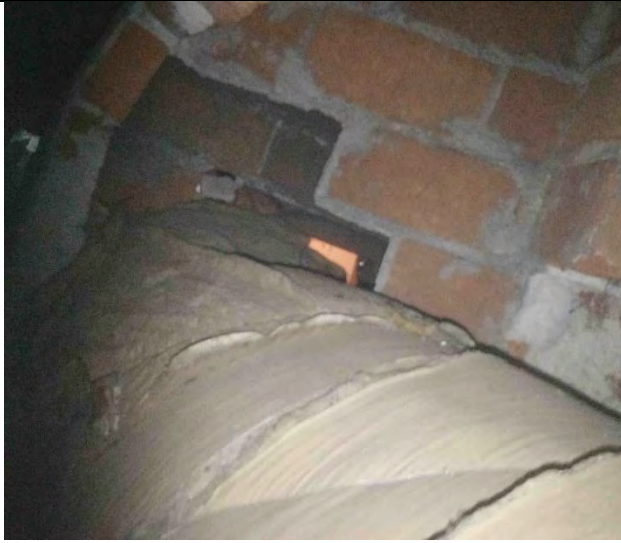
Vanha painovoimainen hormi aukotettu.
