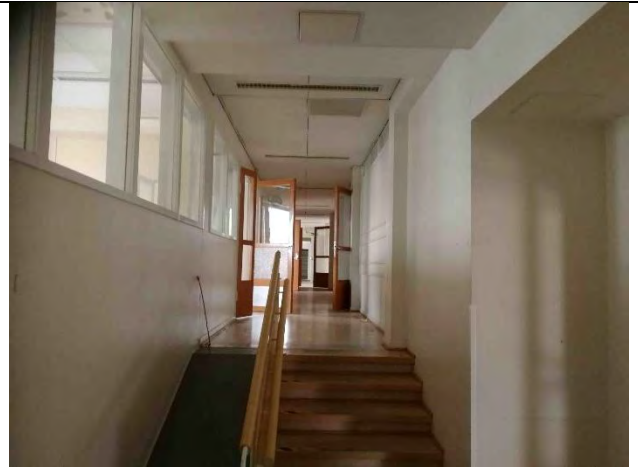
Rakennusta rajaa kantava pilari-/seinälinja.
