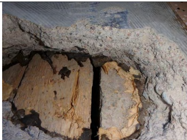
Rakenneavaus VP10. Pintalaatan alla tervapaperi ja puukuitulevy. Avaus palkin ja laudoituksen kohdalta.
