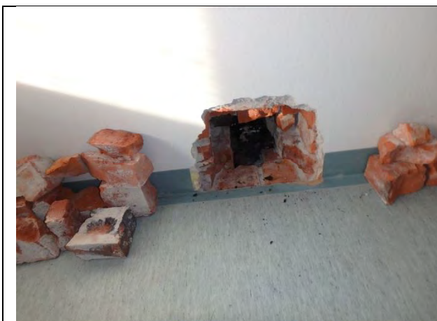
Rakenneavaus ulkoseinän alaosaan tilassa 006.
