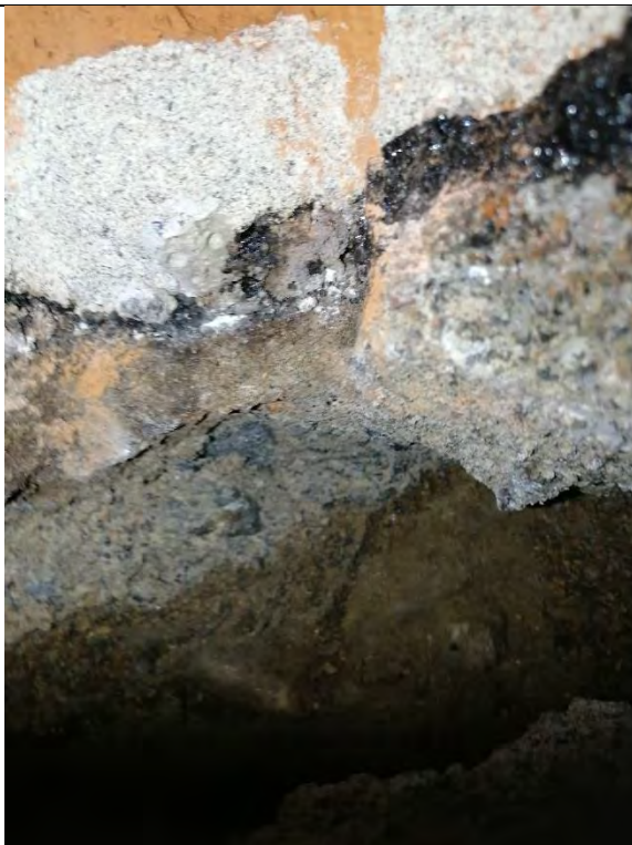
Tiiliseinä lähtee alapohjalaatan alapuolelta. Betonissa on runsaasti luonnonkiviainesta. Tiilimuuraus lähtee bitumisivelyn päältä.
