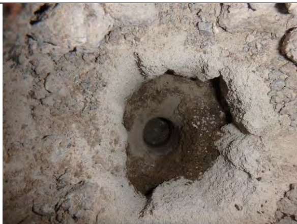
Alapohjan lämmöneristeenä tyypillisesti kaasubetonia.
