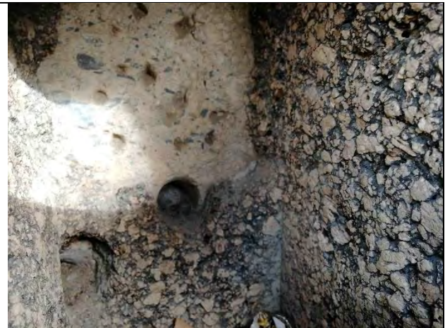
Korvausilmareitissä eristeenä ekspandoitu korkki.
