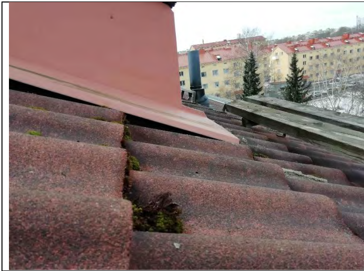
Kulkusiltoja on niukasti ja ne ovat heikossa kunnossa.
