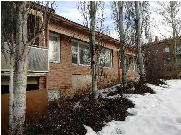
Puita ja pensaita on paikoin lähellä sokkelinjaa.
