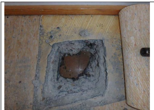
Rakenneavaus VP3, kovalevy pintalaatan alla.
