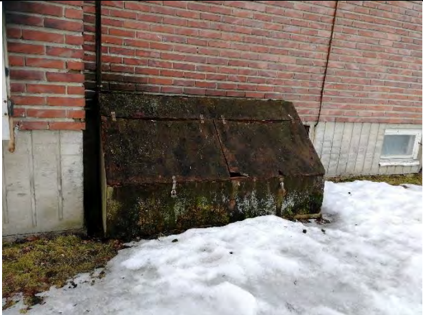
Lahonnut hiekoituslaatikko on tarpeen purkaa.
