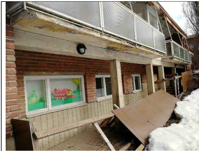
Pilari-palkki-rakenteella kannatetut parvekkeet.
