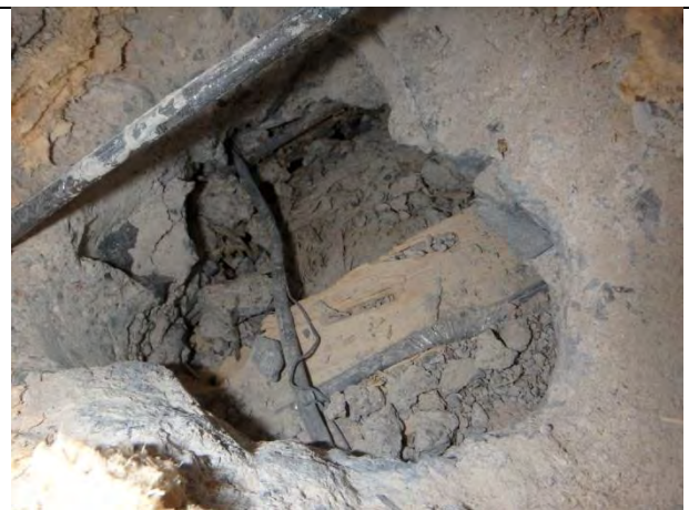
Rakenneavaus VP1, alemman laatan alla laudoitus ja tojalevy.
