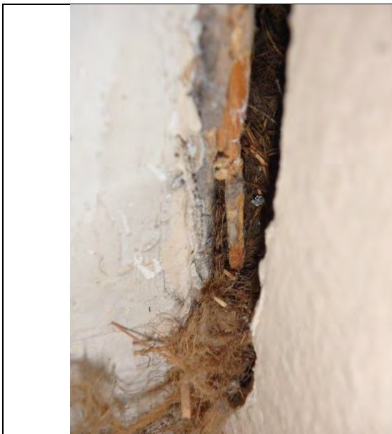
Ikkunoiden ja ulkoseinän liitoksissa on käytetty pellavavärvettä.
