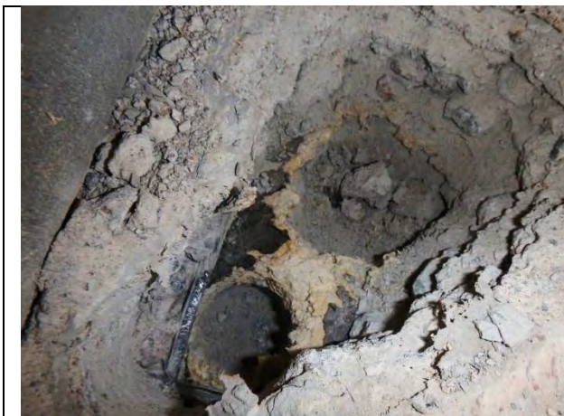
Rakenneavaus VP1, pintalaatan alla tervapaperi ja puukuitulevy.
