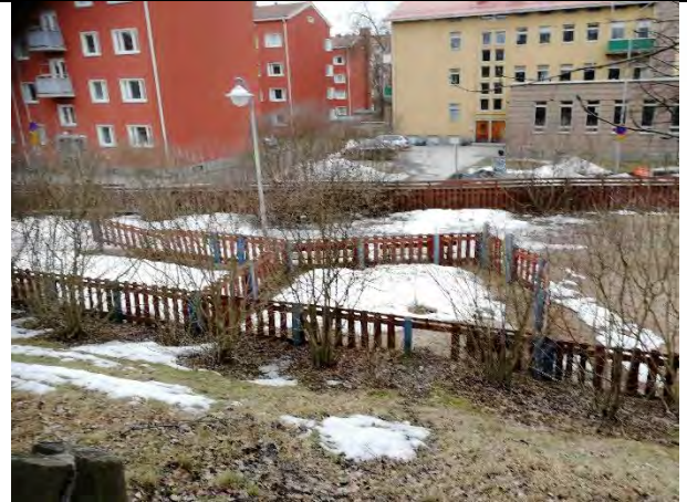
Aitoja on tarpeen huoltomaalata ja paikoin korjata.
