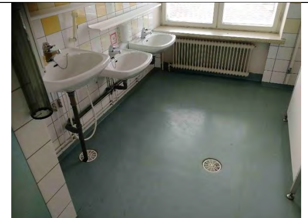
Kiintokalusteet ovat tyydyttävässä kunnossa mutta alapohjan ja välipohjien korjaustarpeet aiheuttavat tarpeen purkaa kalusteet.
