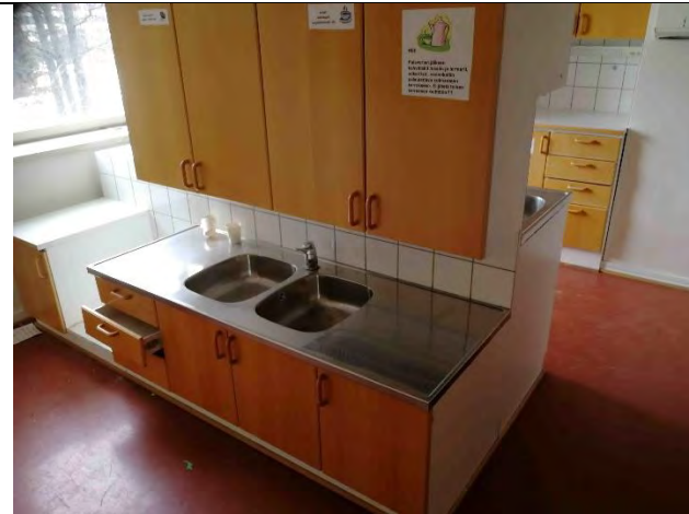
Kiintokalusteet ovat tyydyttävässä kunnossa mutta alapohjan ja välipohjien korjaustarpeet aiheuttavat tarpeen purkaa kalusteet.
