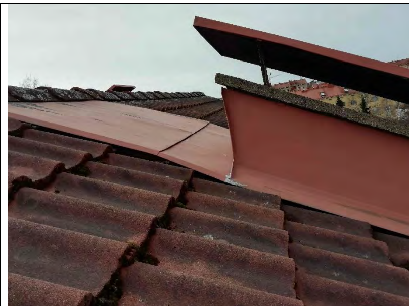
Yleiskuva läpiviennin pellityksestä. Käytetty suoraa peltiä.
