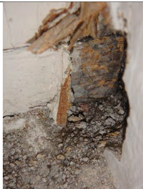
Karmin liitoskohdassa ulkoseinään ei havaittu lahovaurioita.
