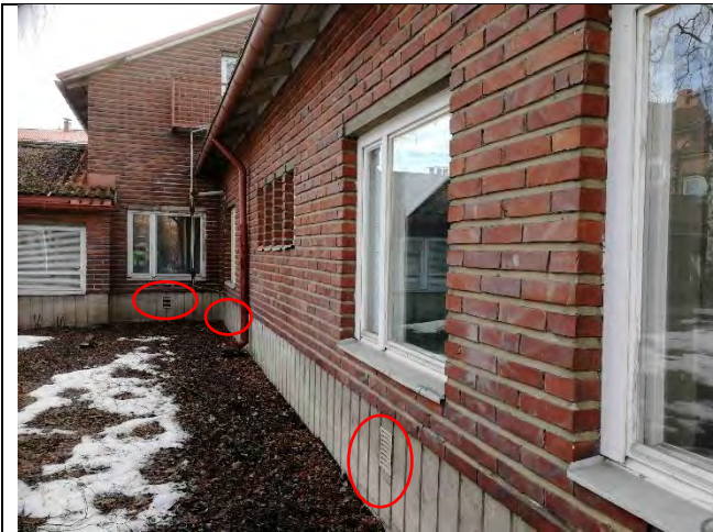
Lämmityspatterien taakse tulevia korvausilmareit- tejä.
