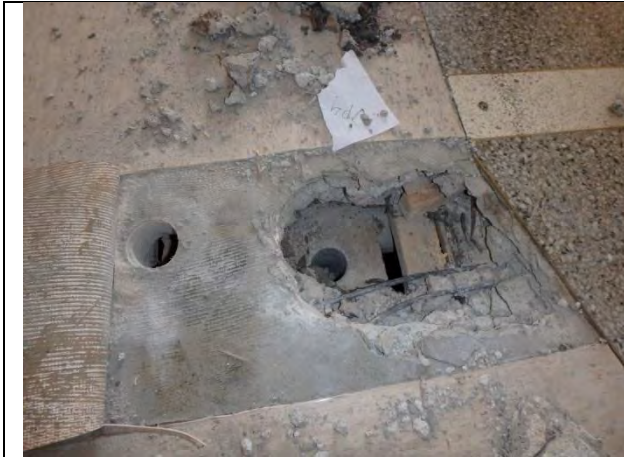
Rakenneavaus VP4 palkin kohdalta.
