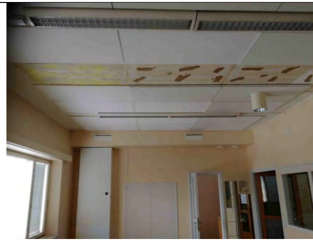
Sisäpuolen kattopintoja on verhottu akustiikkakattolevyillä.
