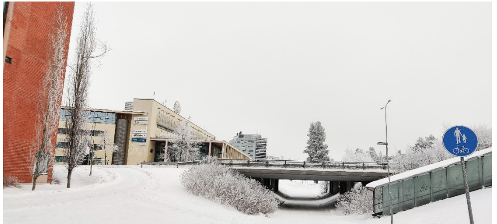
Kuva 19: Valokuva Ahvenniitynraitin alikulkukäytävästä, kuvattu tammikuussa 2021.
