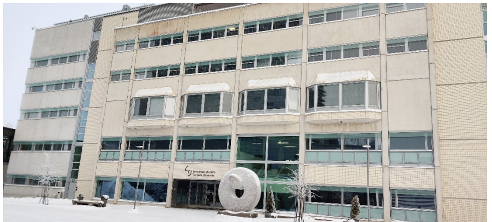
Kuva 8: Valokuva Päärakennuksen pääjulkisivusta, kuvattu tammikuussa 2021.
