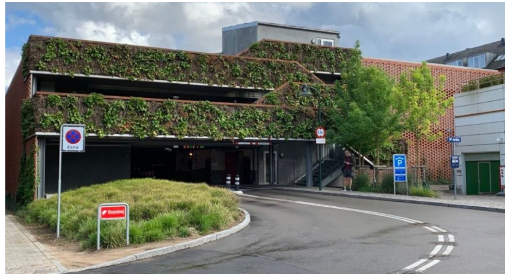
Esimerkkejä pysäköintilaitosten julkisivuista ja köynnöstitutuksista. Kuvat Anna Levonmaa
