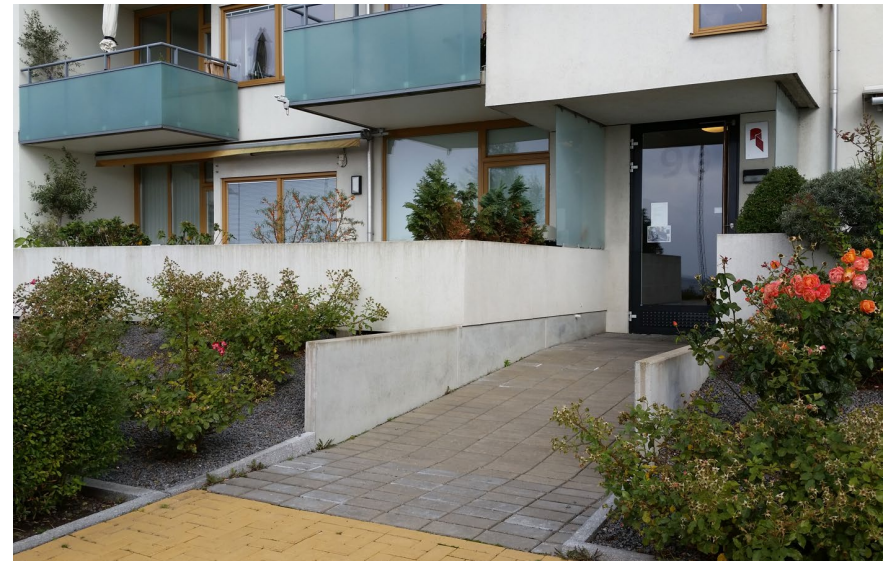
Maantason asuntojen edustalle kaava-alueen pohjoisreunalla rakennetaan muuri.
