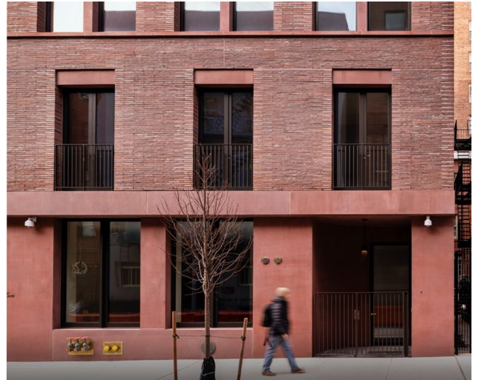
Esimerkki julkisivusta, jossa katutasoin kerros on eri materiaalia, mutta värimaailma on sama. Kuva: Archdaily, James Ewing/JBSA
