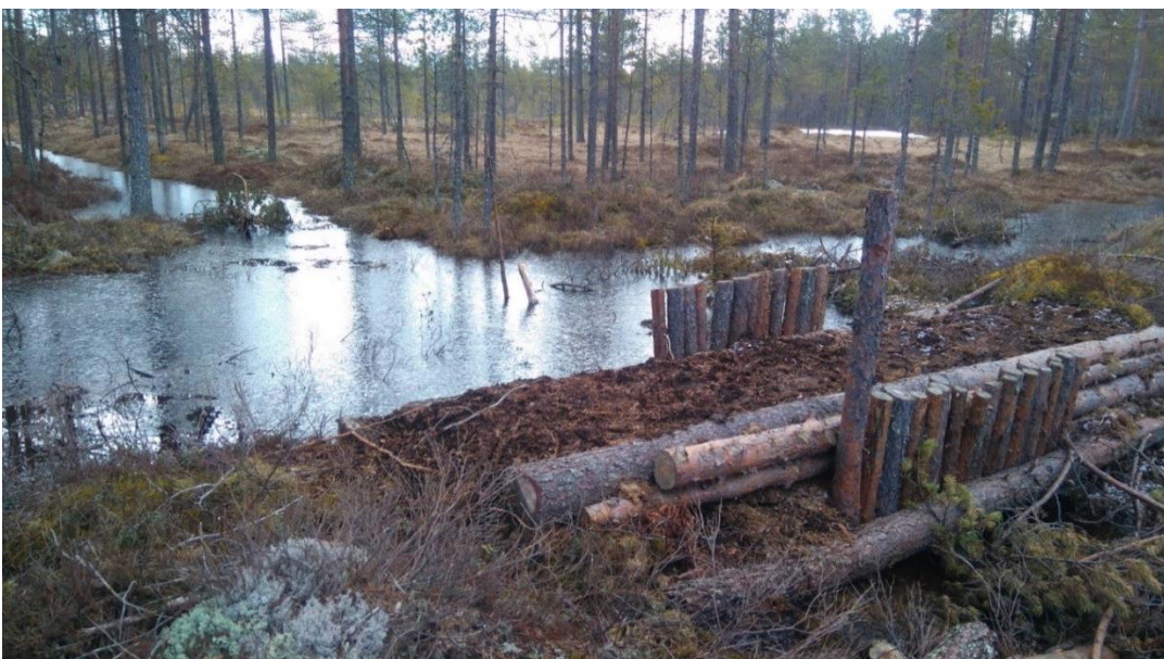
Kuva 17. Käsityönä tehtävän padon malli kuvattuna rakentamista seuraavana keväänä.
