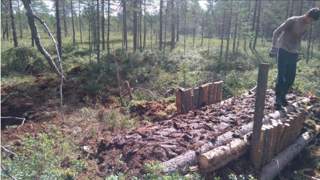
Kuva 16. Käsityönä tehtävän padon malli kuvattuna rakennettaessa.
