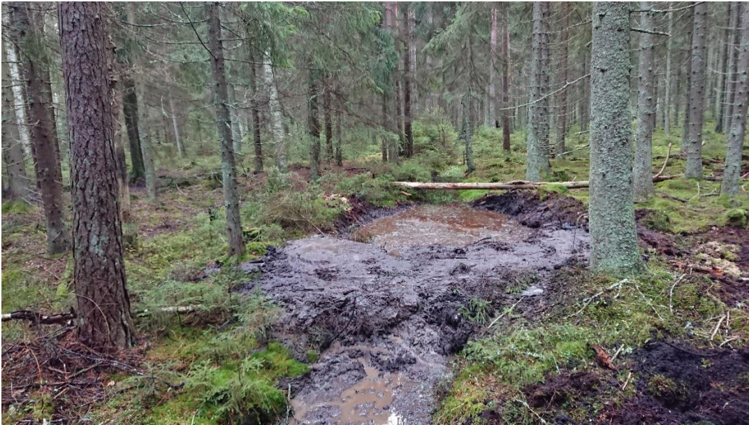
Kuva 15. Esimerkki pienestä kaivinkoneella tehdystä padosta ojassa, jossa ei ole penkkamaita täyttöön. Yleensä padosta kannattaa varmuuden vuoksi tehdä tätä suurempi.
