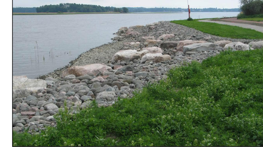
RANTATÖRMÄÄ LOIVENNETAAN MUUTAMISTA KOHDISTA JA VERHOILLAAN LUONNONKIVILLÄ AALLOKOKA KESTÄVÄKSI
