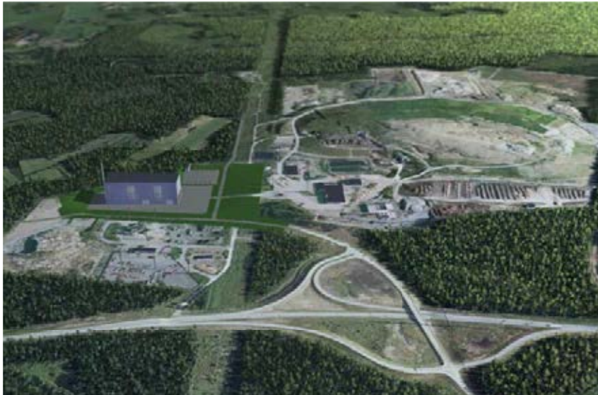
KUVA LENTOKUVA VALLAS OY
