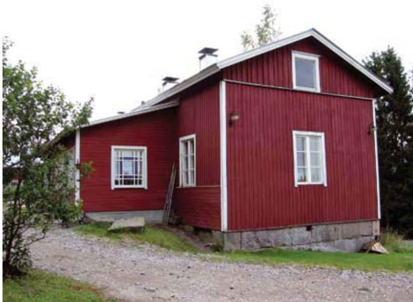
Päärakennuksen luoteispääty. EK 2007
