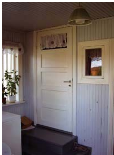
Kuistin panelointia. KN 2007
