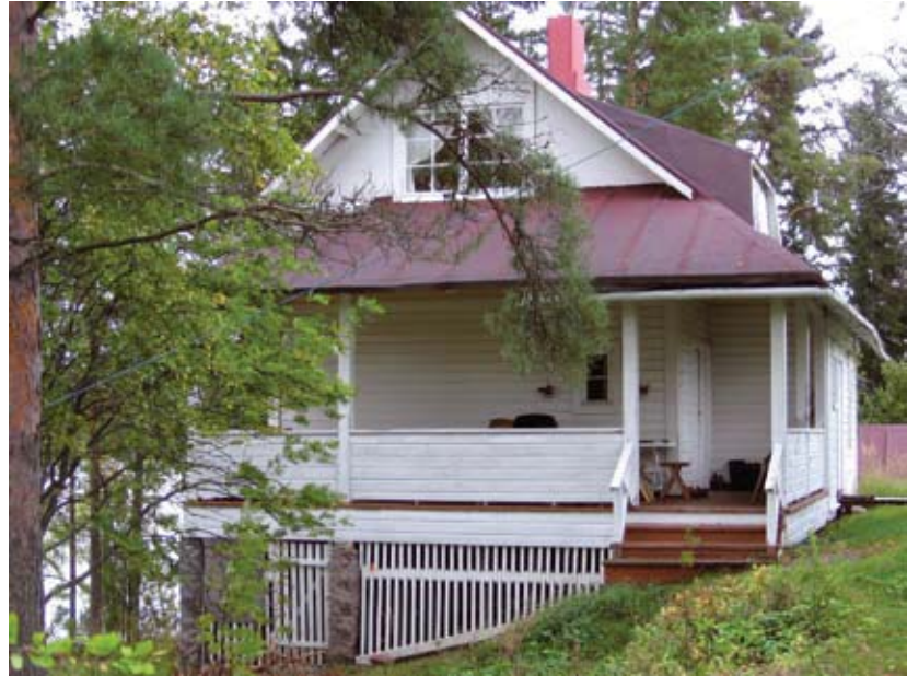
Päärakennuksen lounaispääty. EK 2007
