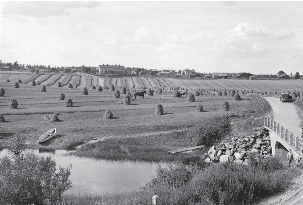
Näkymä vanhalta Kaitavedentien sillalta pohjoiseen. Kuvan ajoitusaika-arvio 1930-1939.
