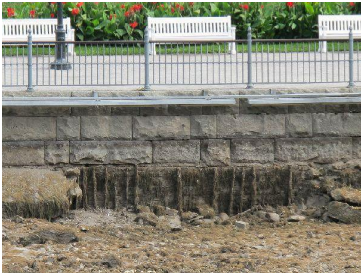
Kosken itäreunan puurakenteita (5C) lännestä. Kuitunen Hannele
