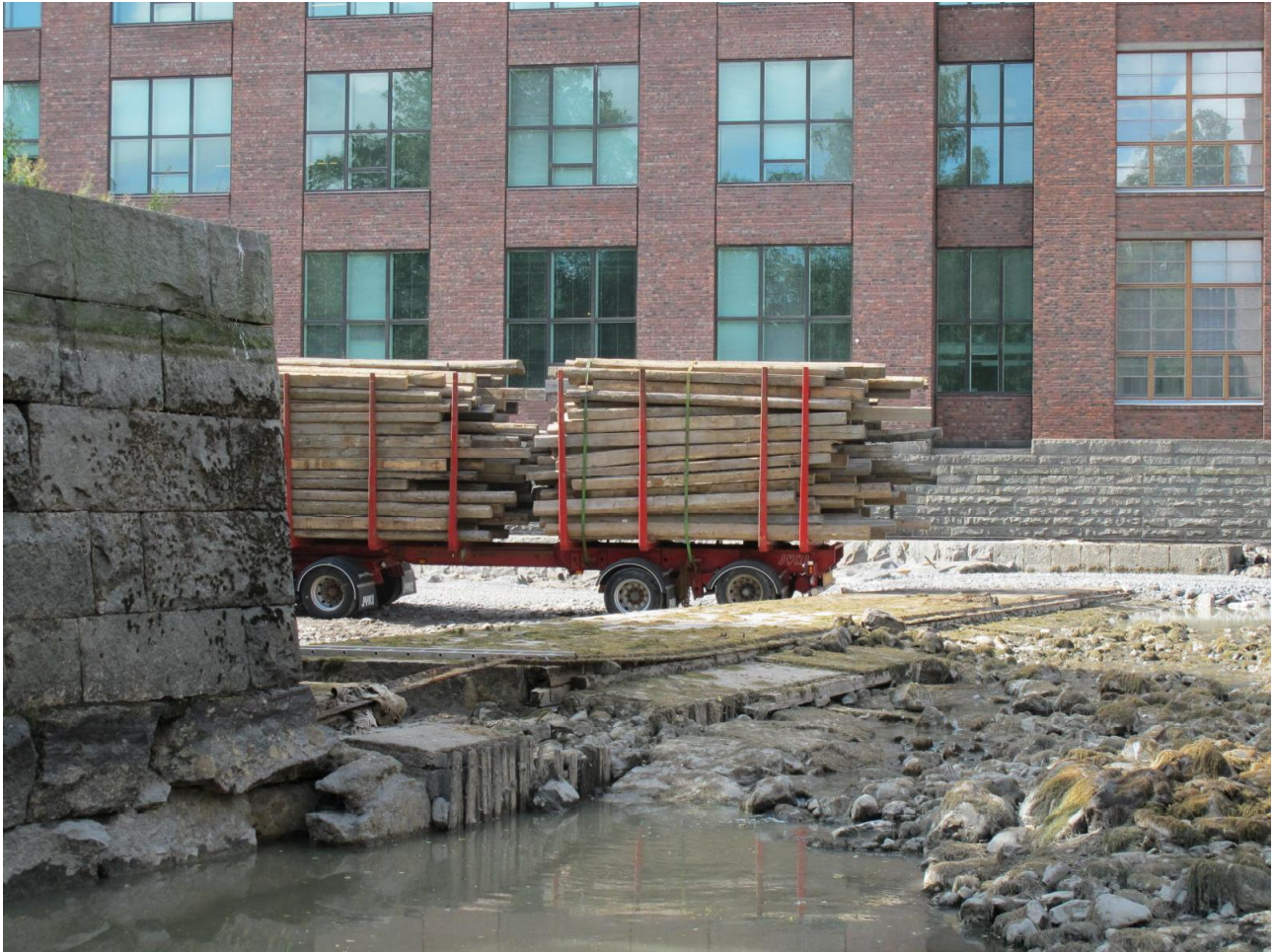
Konsulinsaaren pohjoispään kanavarakenteen kansi. Hannele Kuitunen
