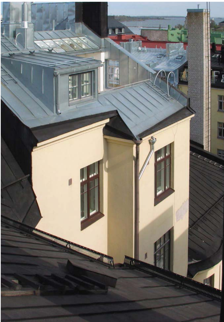
Ullakkorakentamista Helsingissä, arkkitehti: Juha Ilonen
