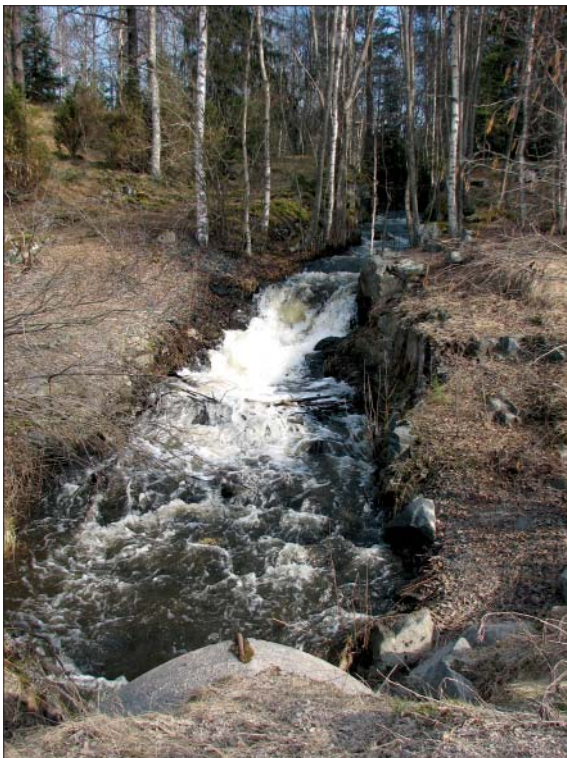
Sorilan Myllypuro Pulesjärventien pohjoispuolella ja eteläpuolella
