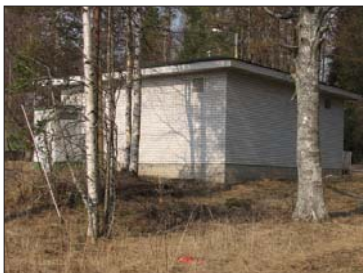
2. Atk- ja teletekniikka rakennus
