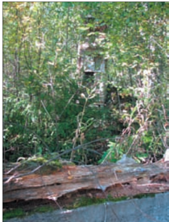
Vanha päärakennuksen palomuuuri
