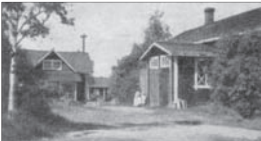
Kovapään tila v. 1931 ilmestyneessä kirjassa Suomen maatilat . Oikealla pärekattoinen päärakennus ennen korotusta ja laajennusta. Vasemmalla sittemmin puretu aitta- ja tallirakennus ja keskellä takana oletettavasti saunarakennus.
