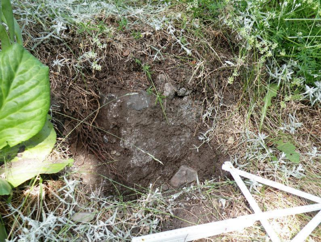
Mäkikatu 24:n betonista kattorakennetta. Kalle Luoto 7.7.2009
