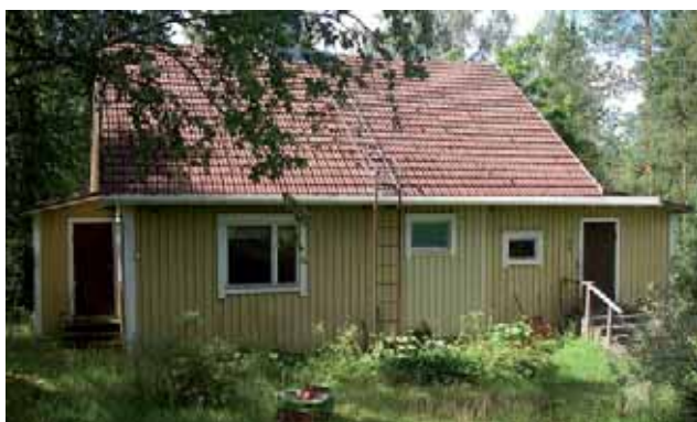
Entinen karjalaistilan päärakennus Viitapohjan suunnalla 2012.
