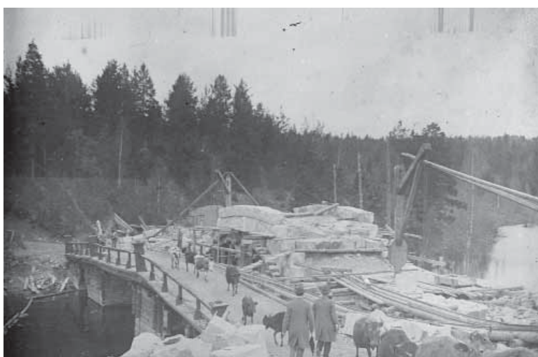
Aunessillan rakennustyömaa 1898. Kuva: Vapriikin kuva-arkisto.
