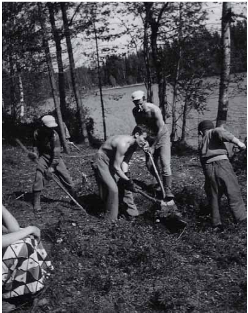
Sotien jälkeen talonrakentaminen kuului vielä jokamiehen taitoihin ja loma-asunto rakennettiin usein talkoovoimin. Kuvassa perataan rantasaunan pohjaa Pirttijärven rannassa 1950-luvun puolivälissä. Kuva: Jarmo Louhimon ja Katri Haimilan kotiarkisto.
