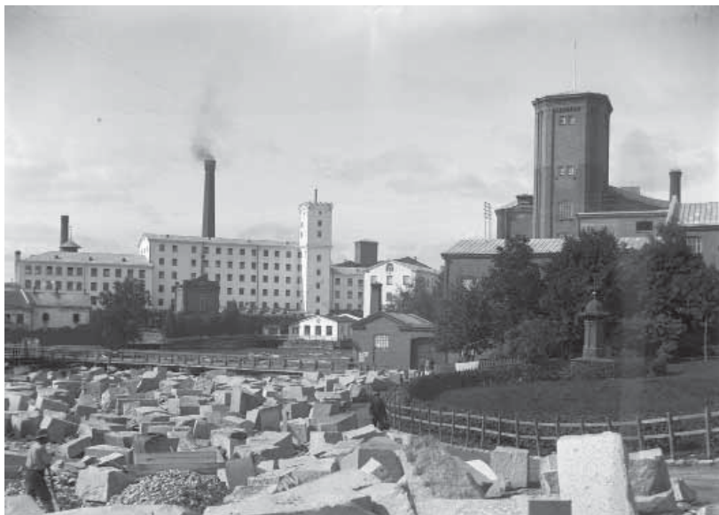
Satakunnan siltaa ja Tammerkosken muuria rakennetaan 1890-luvun lopulla. Kuva: Gestrin, Vapriikin kuva-arkisto.
