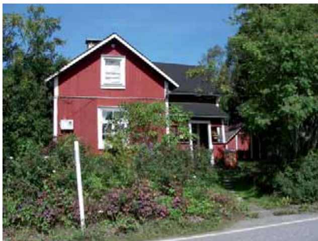
Tiheän kasvillisuuden vuoksi vertailukuvaa ei ole saatu aivan samasta paikasta, mutta rakennus on hyvin tunnistettavissa. Sama karjalaissiirtolaisen talo 2012.
