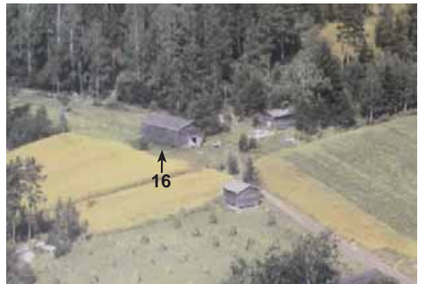
16. YLÄRIIHI (1872-), 1960-luvun ilmakuva. Kuva: Anja Haaviston kotiarkisto.
