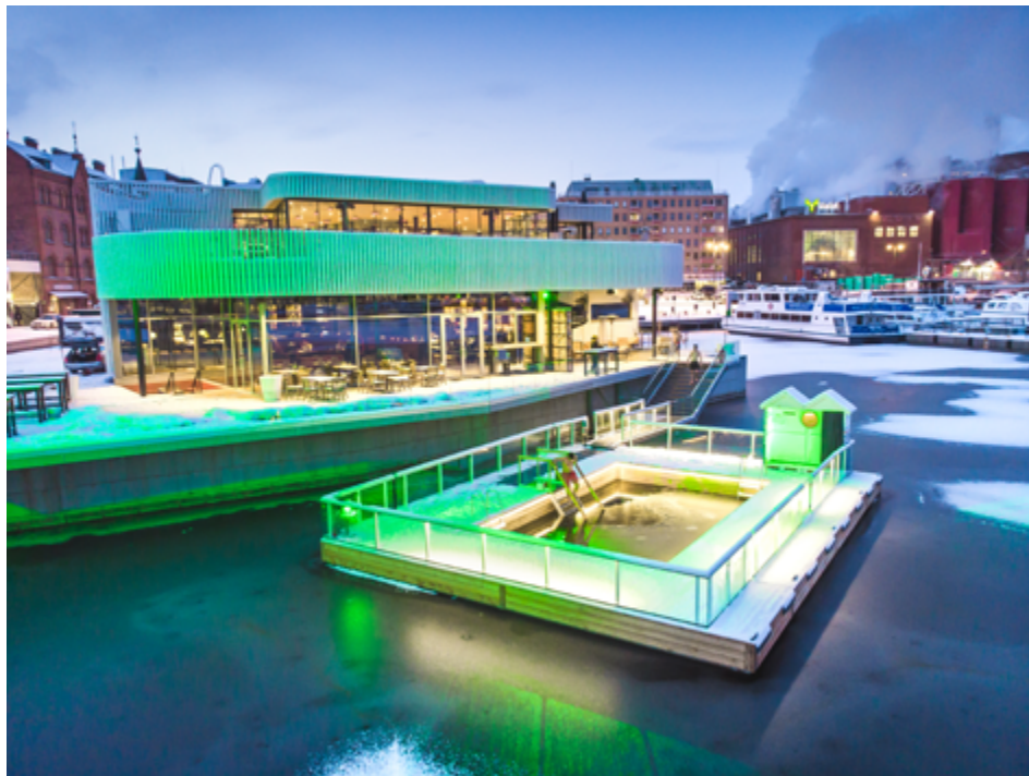
Laukontorin Saunapaviljonki on Tampereen Palvelukiinteistöt Oy:n uusimpia omistuksia. Toiminta rakennuksessa alkoi kesällä 2018. Kuva: Laura Vanzo
