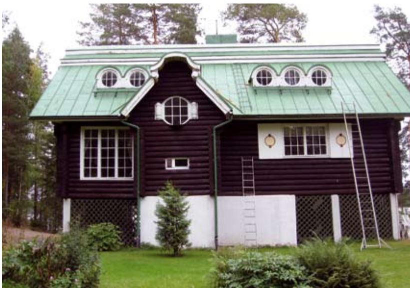
Päärakennuksen länsisivu. EK 2007
