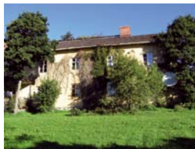
Päärakennuksen eteläisivua. EK 2007
