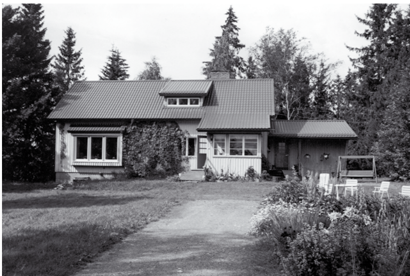
Päärakennus v. 1998. SK 1998
