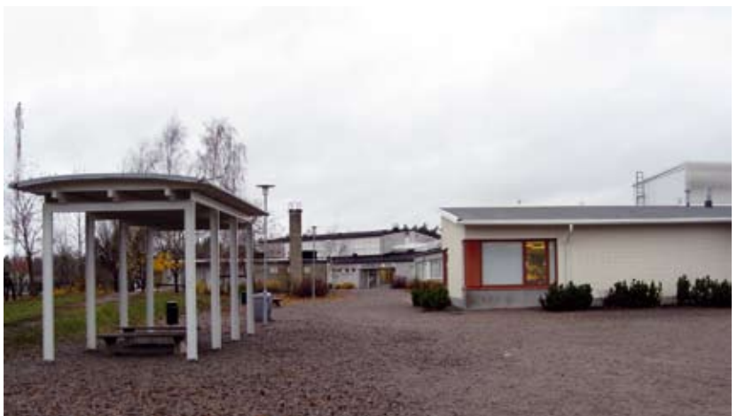
Monessa vaiheessa rakennettu koulu. EK 2007
