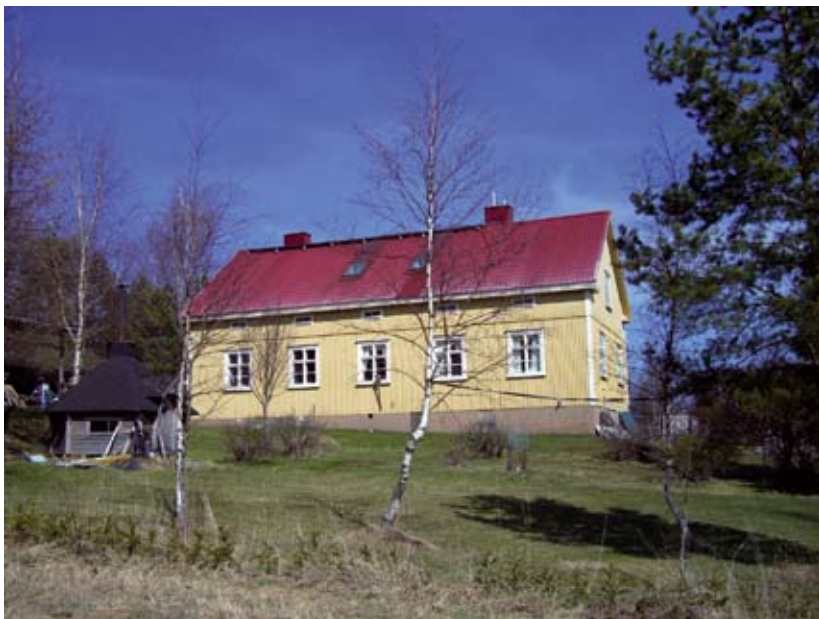
Päärakennuksen länsisivu. JR 2008
