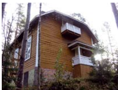
Länsipääty alarinteestä katsottuna. EK 2007
