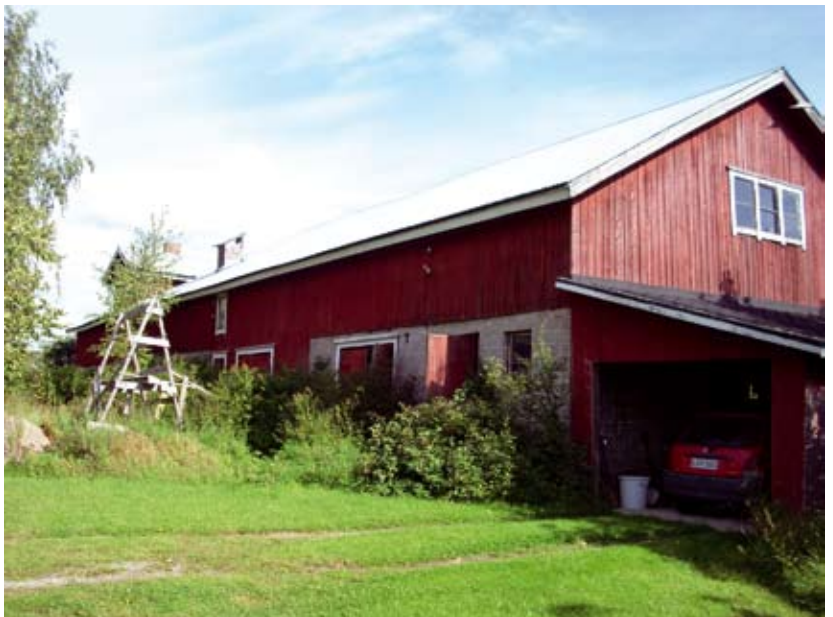
Navetta pihan puolelta. KN 2007
