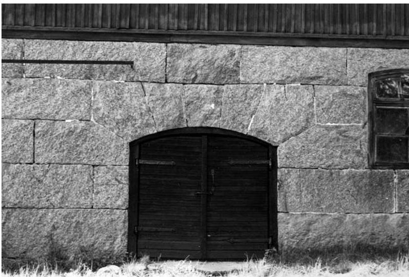
Järvenpään navetan hienoa kivityötä. JV 1999
