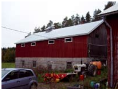
Kiilakivipohjainen navetta. KN 2007
