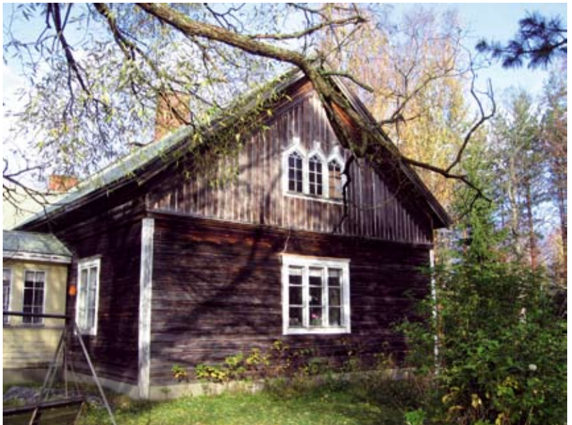
Päärakennuksen itäpääty. EK 2007
