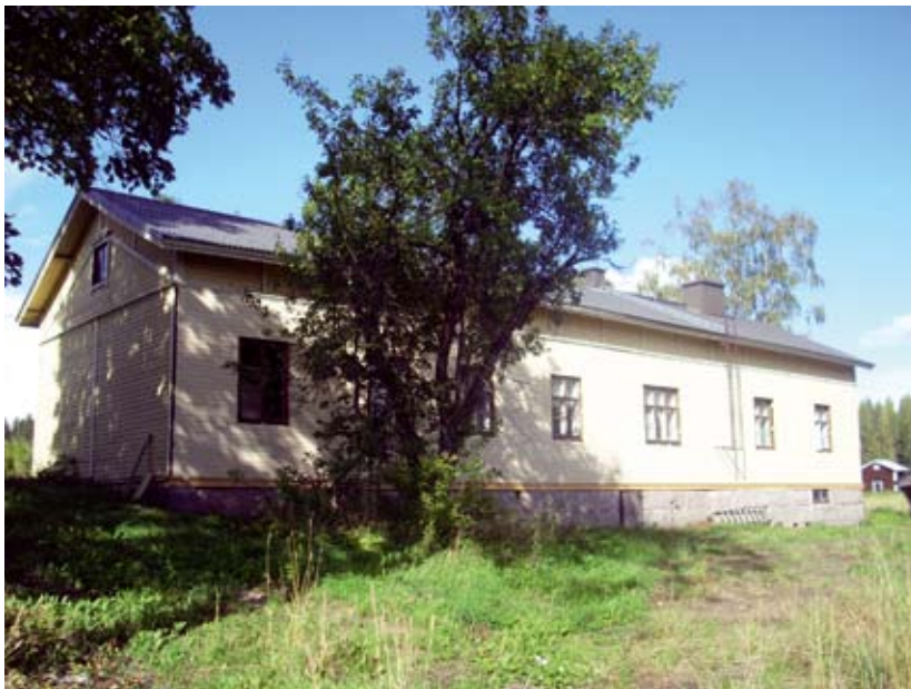
Päärakennuksen takasivu. KN 2007
