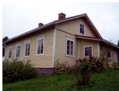
Uudempi talo pohjoisesta. KN 2007
