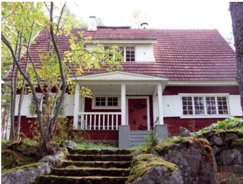
Päärakennuksen länsisivu. EK 2007
