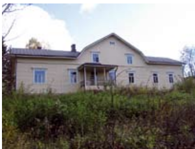
Päärakennuksen länsisivu. EK 2007
