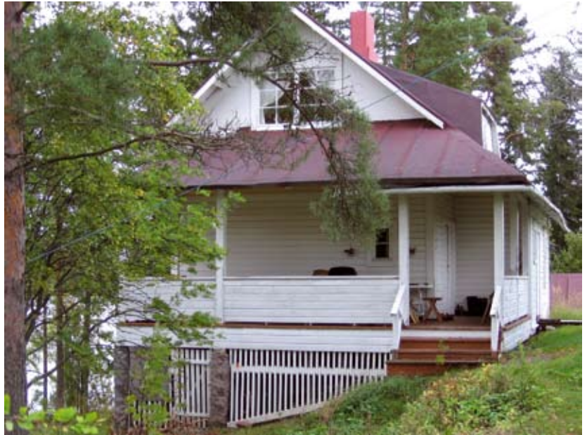
Päärakennuksen lounaispääty. EK 2007
