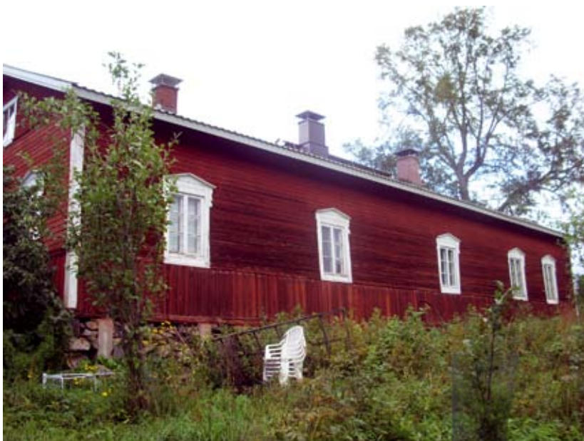
Päärakennuksen länsisivu. KN 2007
