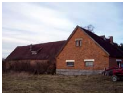
Tiilinavetta idästä. JR 2008
