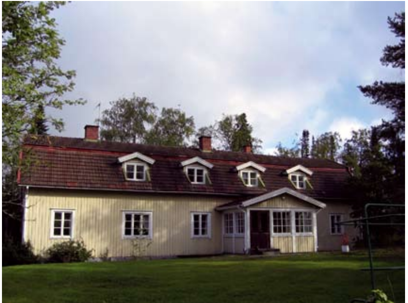
Päärakennuksen eteläisivu. EK 2007
