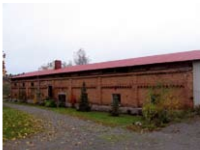
Tiilinavetan pihasisivu. EK 2007
