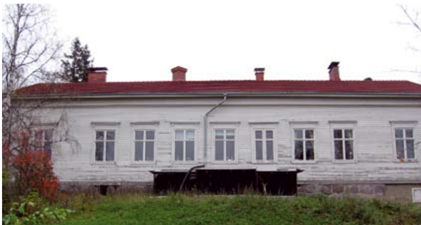
Koulun länsisivulle palautetaan purettu kuisti. EK 2007
