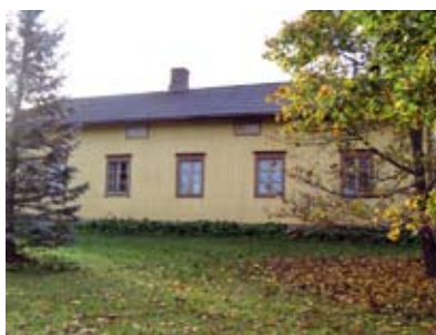
Päärakennuksen takasivu. EK 2007
