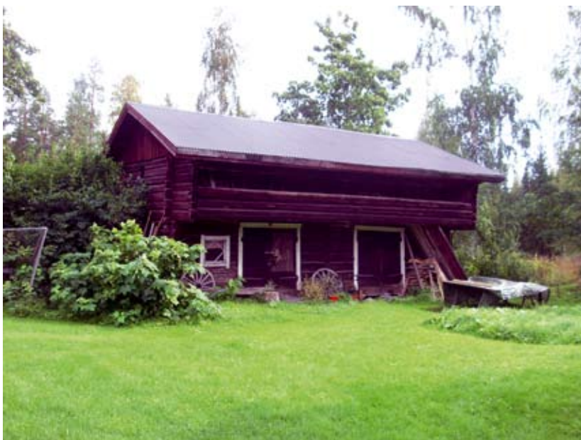
Luhtiaitta pihan puolelta. KN 2007
