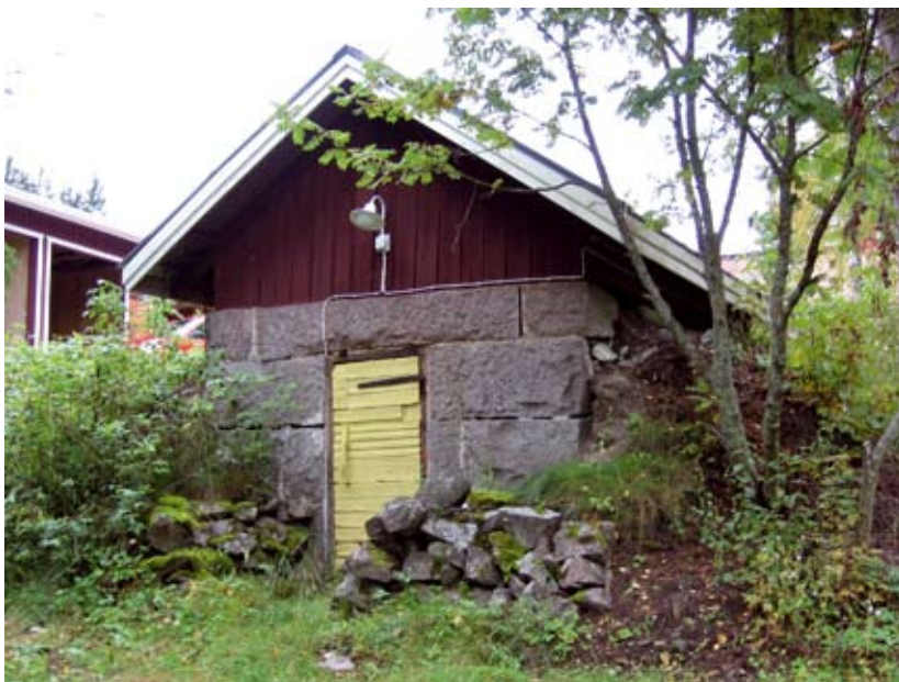
Kellarin kiilakiviseinää. EK 2007
