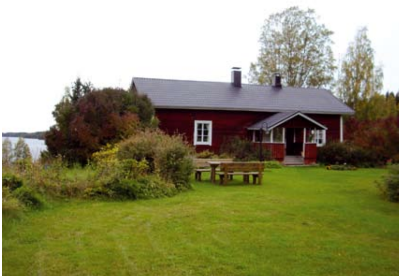
Päärakennuksen pihasivu. KN 2007
