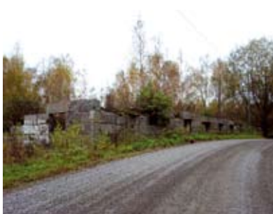
Kun katto pettää, muurit jäävät. KN 2007
