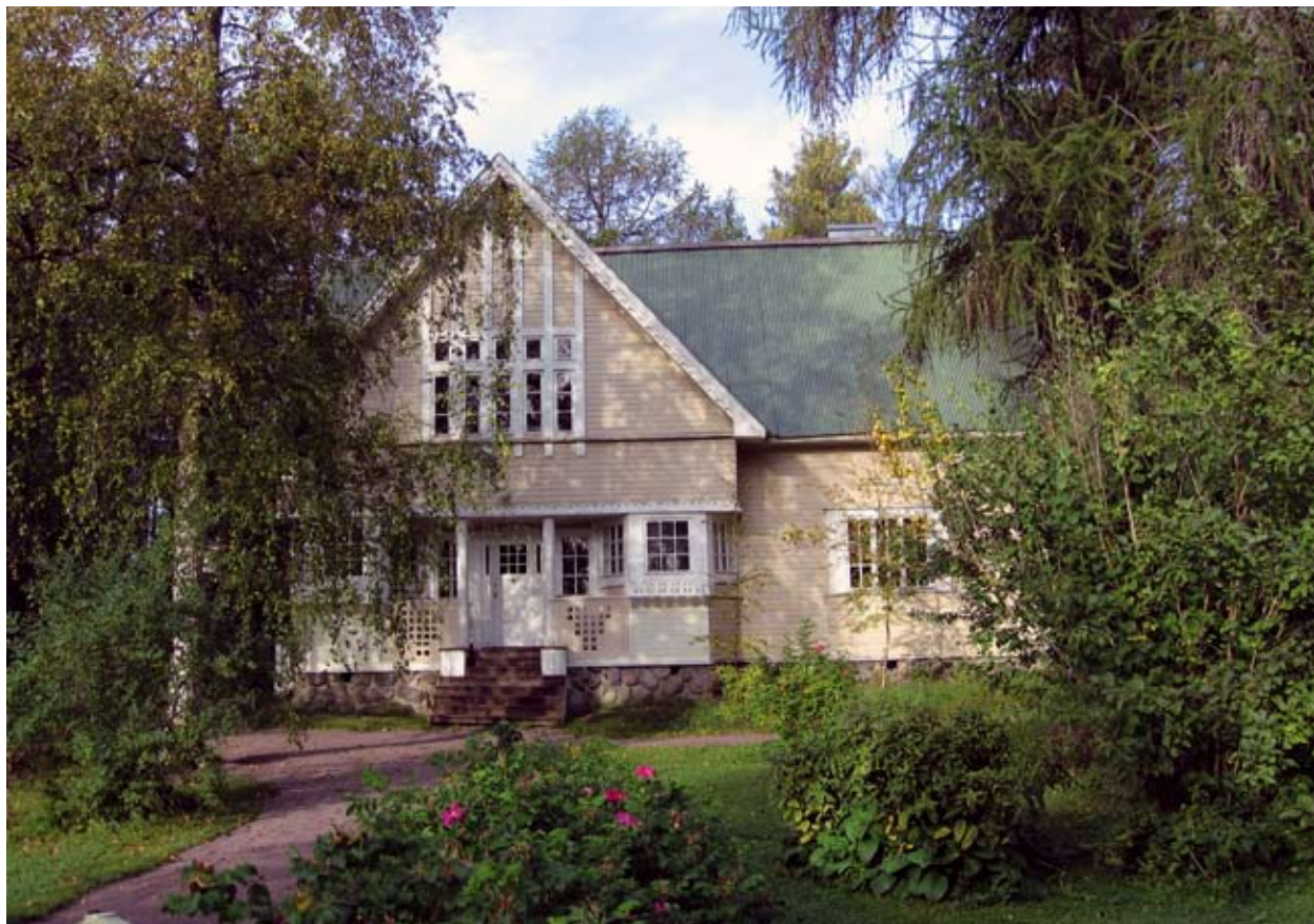
Päärakennuksen sisääntulosivu. EK 2007
