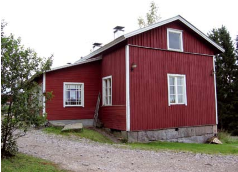
Päärakennuksen luoteispääty. EK 2007
