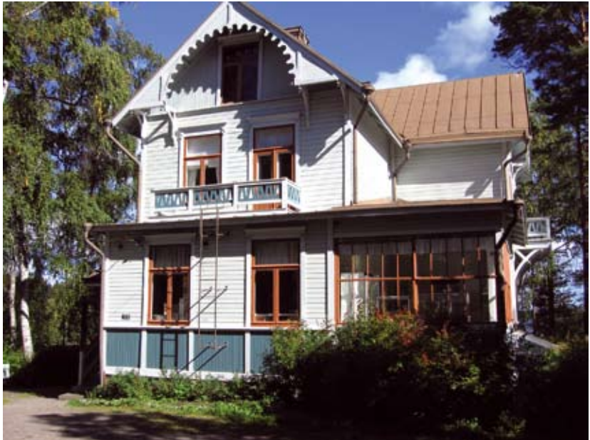
Päärakennuksen monimuotoinen länsipääty. EK 2007
