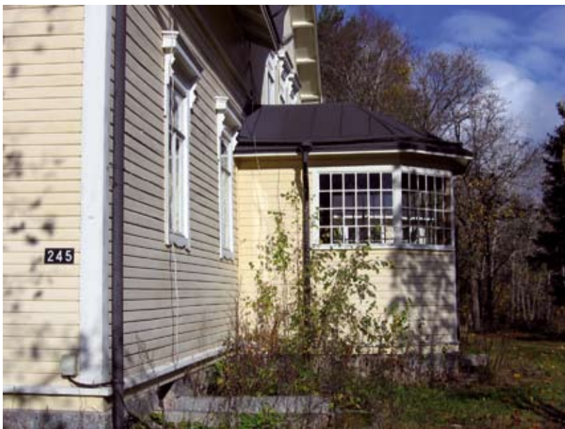
Päärakennuksen umpikuisti. EK 2007
