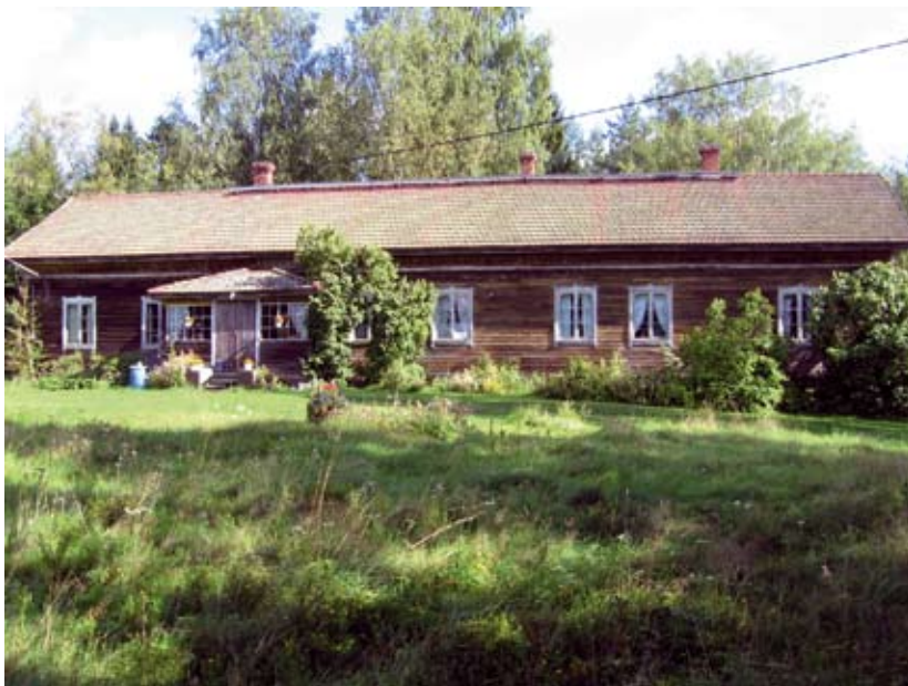
Päärakennuksen länsisivu. EK 2007
