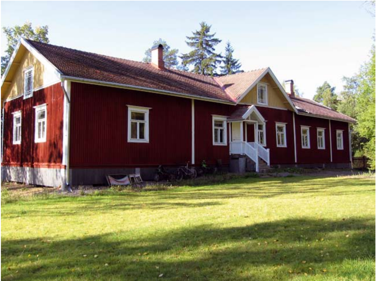
Päärakennuksen pohjoissivu. EK 2007
