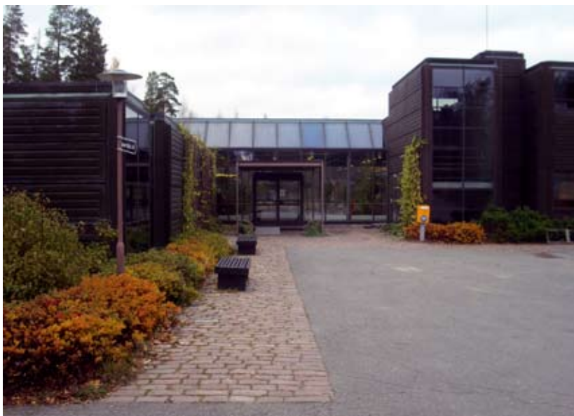
Päärakennuksen sisäänkäynti. KN 2007
