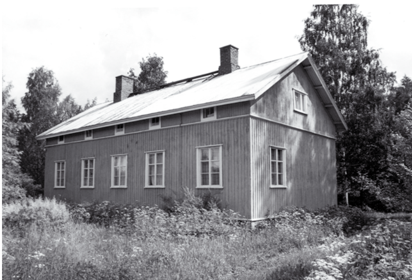
Päärakennuksen länsisivu. SK 1998
