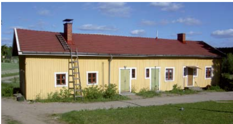
Piharakennuksen pihasivu. Jukka Kolehmainen 2008
