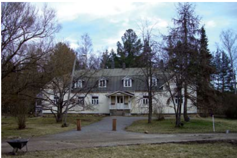
Päärakennus etelästä. JR 2008
