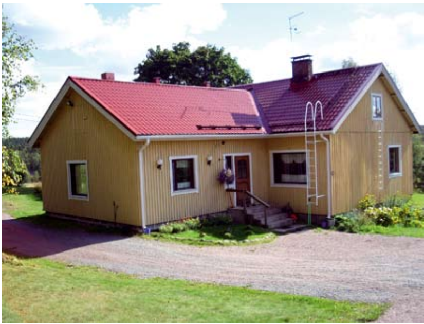
Päärakennus luoteesta. KN 2007
