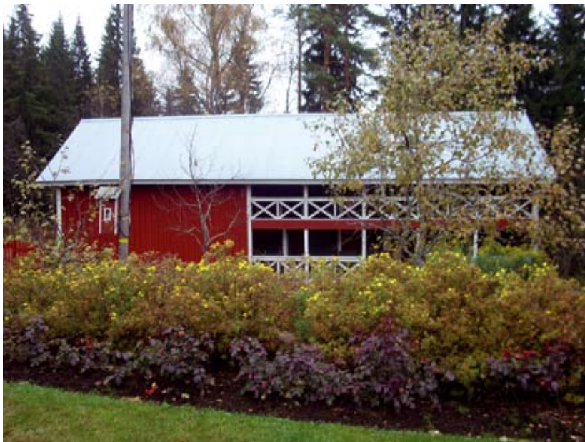
Luhtiaitta pihan puolelta. KN 2007
