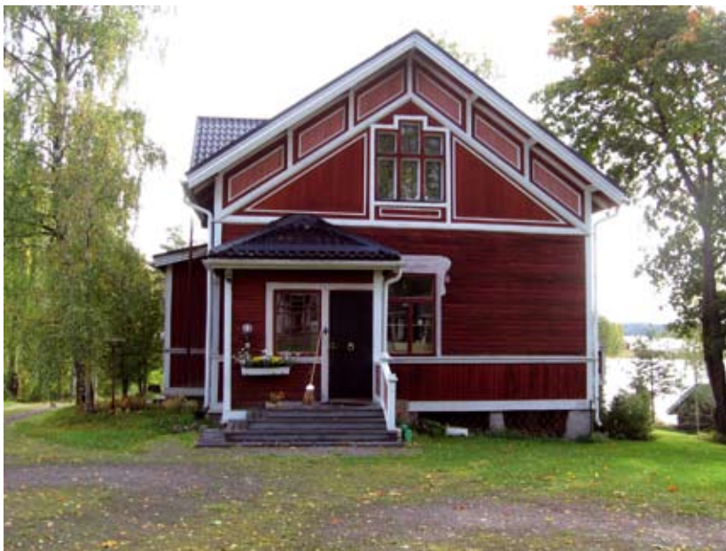
Päärakennuksen länsipääty. EK 2007
