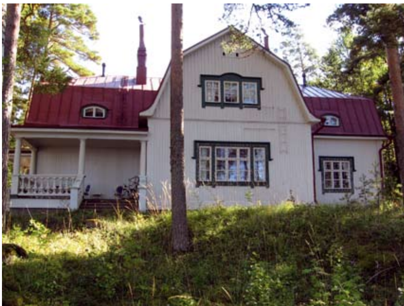
Päärakennuksen sivu järvelle. EK 2007
