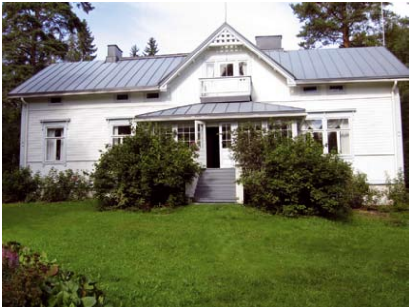
Päärakennuksen eteläsivu. EK 2007
