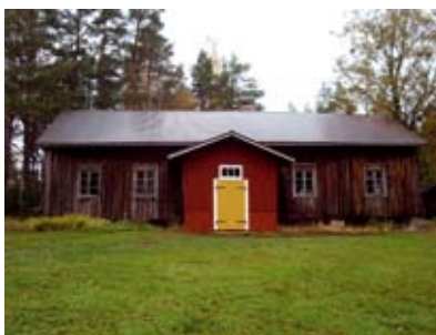
Vanha asuinrakennus, kunnostustyöt aloitettu. KN 2007
