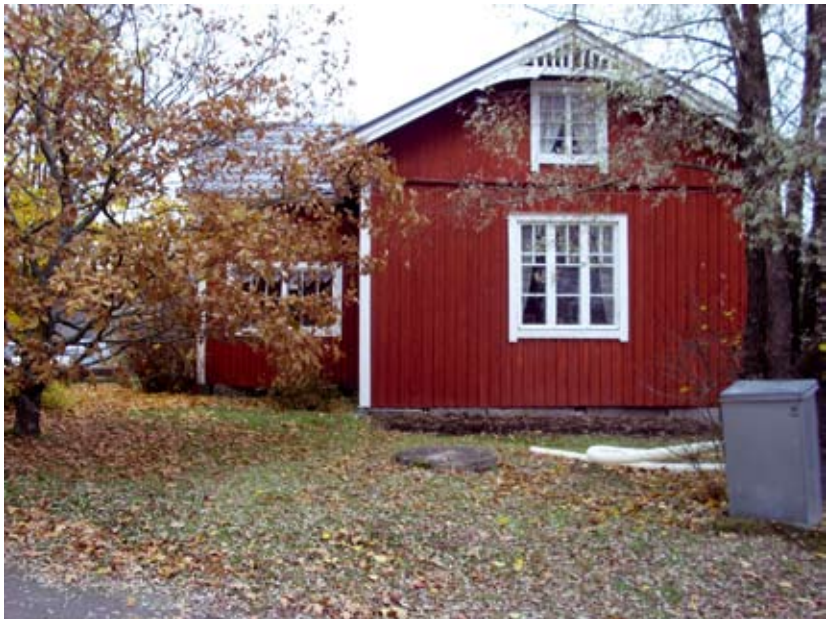
Vanhan asuinrakennuksen länsipääty. KN 2007
