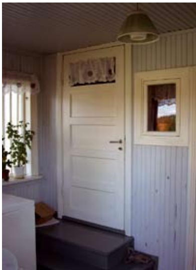
Kuistin panelointia. KN 2007
