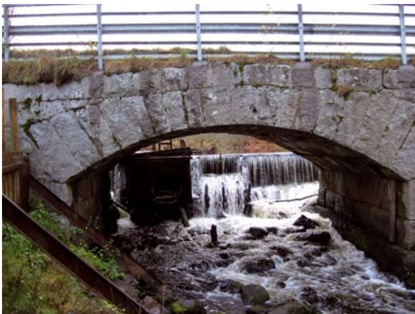
Teräkosken silta nykyisin. EK 2007
