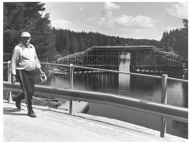
Kaitavedensillan rakennustyömaa 1980-luvulla. (Työväenmuseo Werstas).
