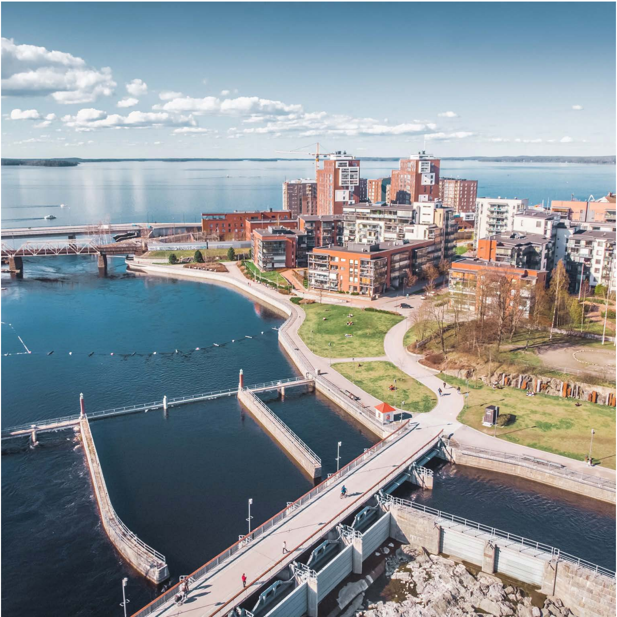
Kuva 39: Kasvava kaupunki rakentaa paljon niin asuntoja, palveluja kuin kaupunki-infraa. Tampere ottaa käyttöön hiilineutraa-liuskriteerit koko maankäytön prosessissa, laskee rakentamisen hiilijalanjäljen ja minimoi sen mm. puurakentamisella, energia-tehokkaalla rakentamisella ja hyödyntämällä mahdollisimman paljon uusiomateriaaleja. Kuva: Visit Tampere Oy / Laura Vanzo.
