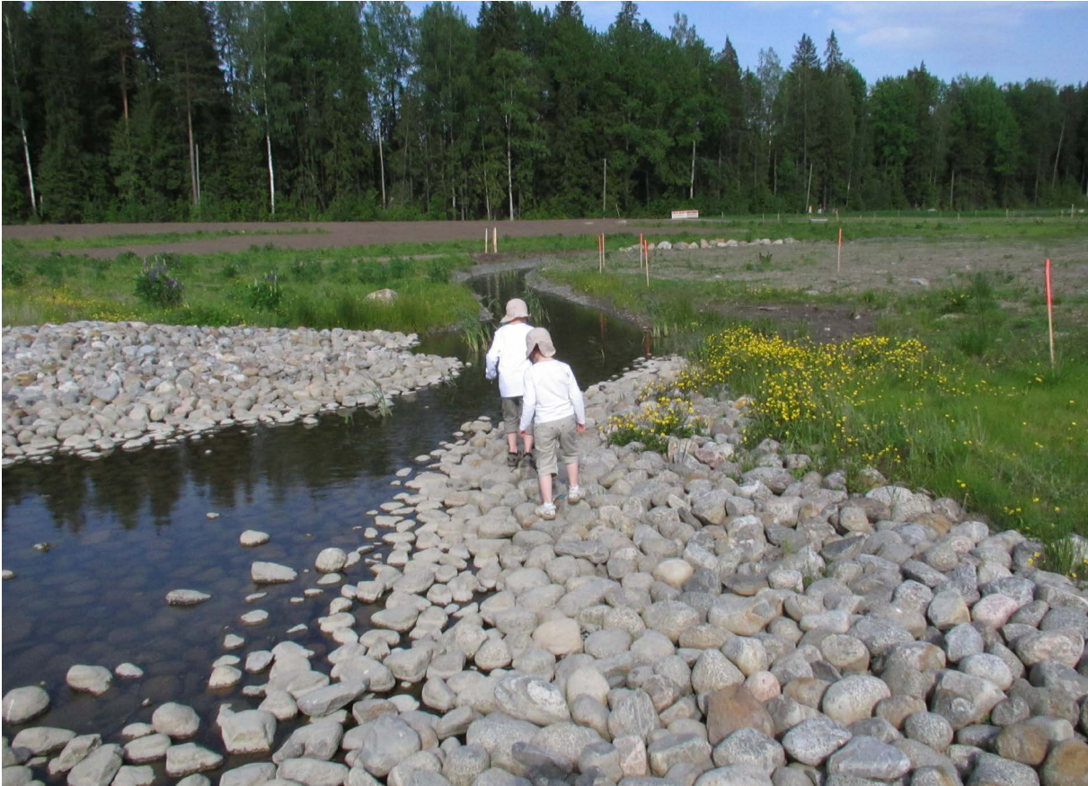
Kuva 64: Tampereella kehitetään aktiivisesti luonnonmukaisia hulevesijärjestelmiä. Esimerkiksi Vuorekseen on rakennettu yksi Suomen laajimmista hulevesialueista, joka toimii samalla asukkaiden virkistysalueena. Veden laatua ja virtaamaa seurataan automaattisin mittauksin ympärivuotisesti. Mittausten avulla saadaan tietoa nykyisten hulevesijärjestelmän kyvystä puhdistaa hulevesiä ja pienentää virtaamia. Urban Nature Labs -projektissa pilotoidaan kaupunkien hulevesien hallintaa luontoperustais- ten järjestelmien avulla yhteistyössä kaupungin asukkaiden kanssa eri puolilla kaupunkia, mm. Hiedanrannassa. Kuva: Tampereen kaupunki.
