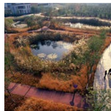
Hulevesipainanne Stormwater fields
