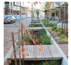
Lineaarinen hulevesiaihe Stormwater element in street
