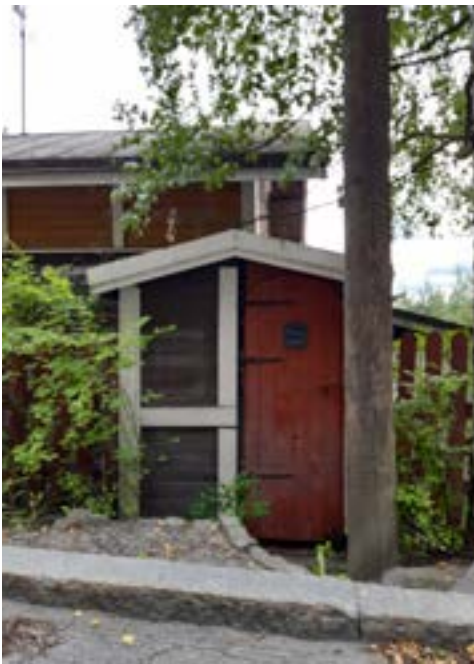
Teerentie 4 . Rakennuksen pääsisäänkäynti on Järvensivuntien puolella.
