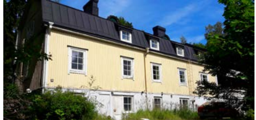
Osoitteessa Nokiantie 50 sijaitseva palstoittamalla syntynyt rakennus, jonka julkisivu on säilynyt ilman suuria muutoksia. Rakennusvuosi ei ole tiedossa.
