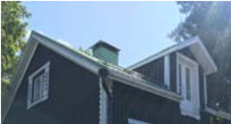
Kattolyhty sekä koristeet ikkunoissa ja nurkkalau-doissa luovat omaleimaisen ilmeen Lumikonkatu 6 rakennukseen, joka on vuodelta 1937.
