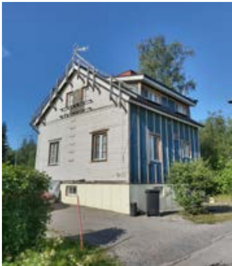
Osoitteessa Vesiperäncatu 13 sijaitsee vuonna 1926 rakennettu talo, jota remontoidaan. Remontissa esimerkiksi suurennetaan kadun puoleisia ikkunoita ja toisen kerroksen huonekorkeutta on saatu korkeammaksi lisäämällä kadun puoleiselle kattolappeelle kattouloke.
