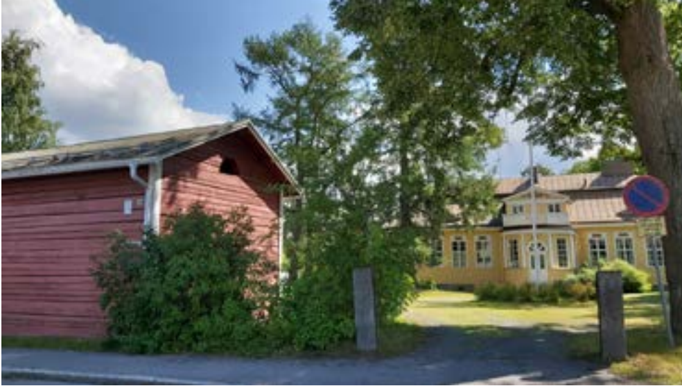
Messukylän vanha Pappila, jonka on suunnitellut arkkitehtitoimisto Björklund-Myntti vuonna 1919. Rakennus edustaa klassista tyyliä ja se on peruskorjattu vuonna 1982. Rakennus toimii nykyään seurakunnan toimitiloina. Osoite Tanhuankatu 40.
