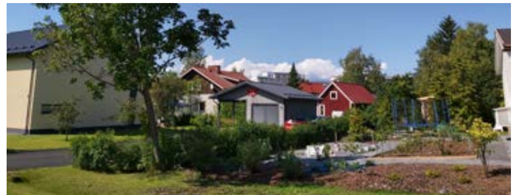
Eri vuosikymmeninä rakennettuja taloja yhdistää jyrkkä harjakatto. Osoitteesta Kukkuraisenkatu 9 on purettu vuonna 2011 vuonna 1927 rakennettu talo uuden, kuvassa näkyvän, kivitalon tieltä. Tontilla on edelleen voimassa vuoden 1959 asemakaava.
