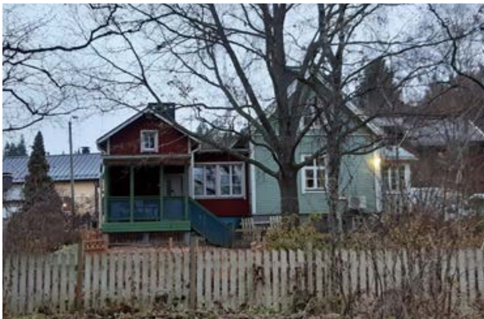
Sulkakatu 1: Vanhaa sinistä rakennusta on laajennettu punaisella osalla 2000-luvulla
