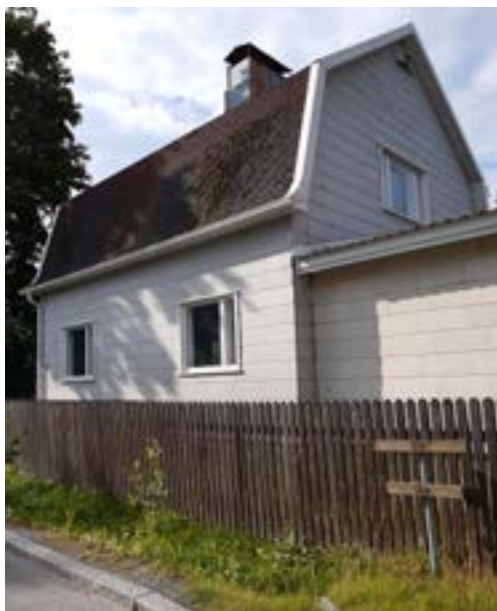
Saarikorventie 5: vanha rakennus on saanut levyverhouksen
