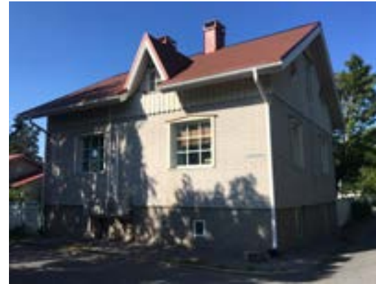
Tiiliverhouksella vahvasti uudistettu talo Rautapellonkadun ja Kankaankujan kulmassa. Talon tarkka rakennusajankohta ei ole tiedossa, mutta se on valmistunut todennäköisesti ennen 1930-lukua.
