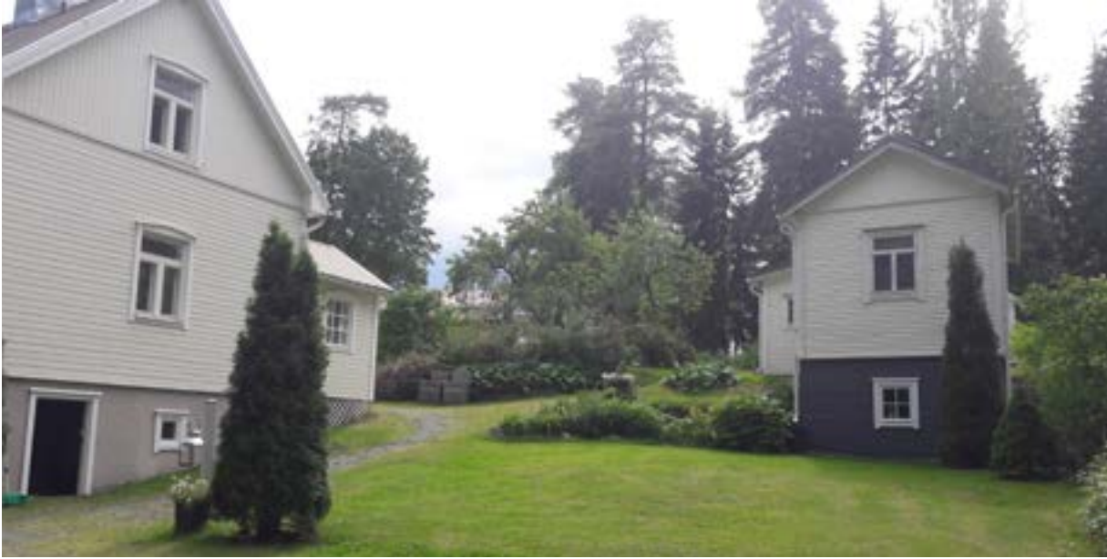
Ketostenkatu 19 pihapiiriin kuuluu pieni vuonna 1935 valmistunut asuinrakennus ja suurempi asuinrakennus, jonka tarka rakennusvuosi ei ole tiedossa. Oletettavasti se on samalta aikakaudelta kuin pienempikin rakennus.
