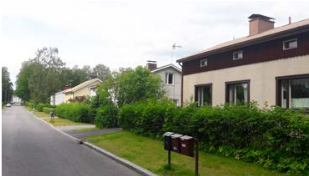
Jälleenrakentamiskauden pientaloja, joiden julkisivuja on uusittu modernimmeilla vuorausmateriaaleilla. Kuvassa Ketostenkatu 28-32.
