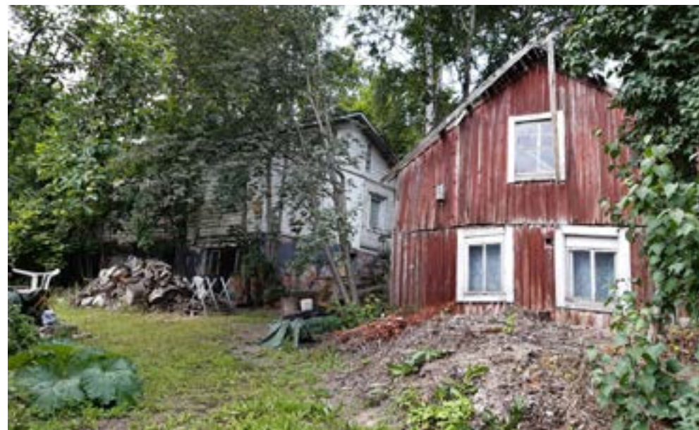
Järvensivuntie 49: Pää- ja talousrakennus. Osa Järvensivun vanhoista rakennuksista on huonossa kunnossa.
