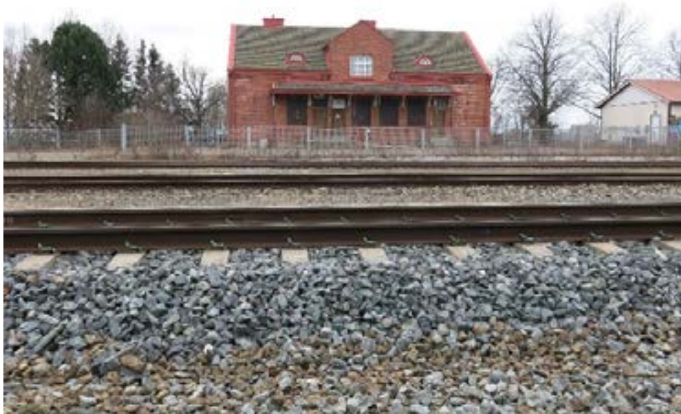
Lielahden asema osoitteessa Rahtimiehenkatu 8 kuvastaa punatiilistä teollisuusperintöä. Asema on rakennettu vuonna 1926. Kuva: Vapriikin kuva-arkisto.
