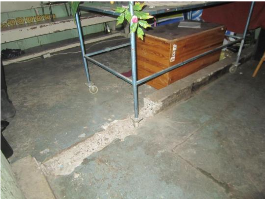
Kuva 6. Lattian pintalaatasta otettiin näyte asbestianalyysiä varten. Näyte ei sisällä asbestia.
