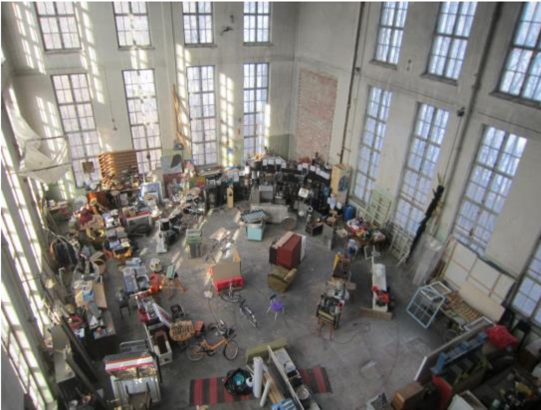
Kuva 5. Lämpövoimalasalin lattia on betonia. Tilassa ei havaittu mahdollisesti asbestia sisältäviä putkieristeitä.
