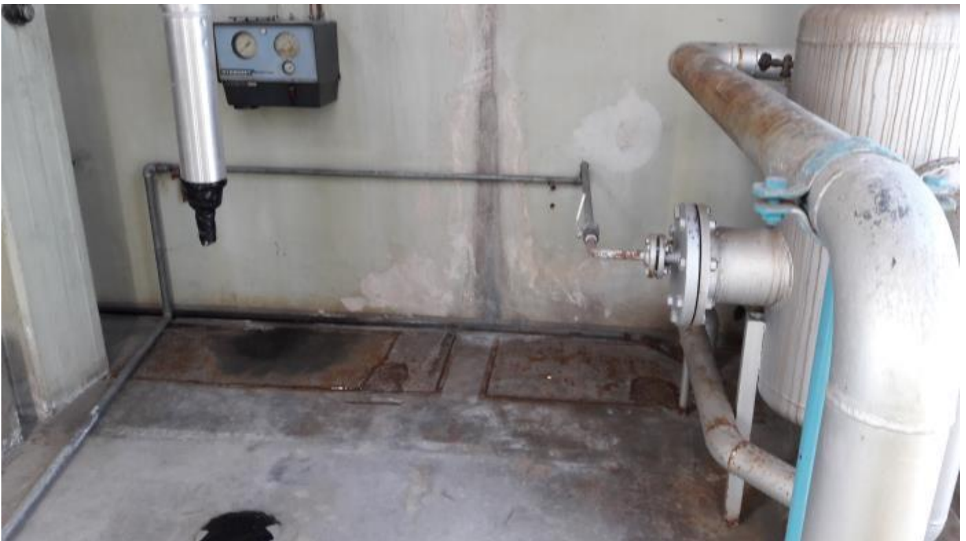
Kuva 4. Kerrosten lattiat ovat betonia. Rakennuksessa ei havaittu magnesiainmassalattioita.
