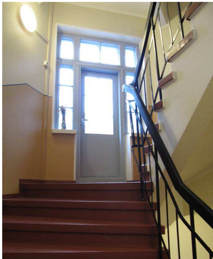
Kuva 7) Porrashuoneet ovat arkkitehtuuriltaan aikakaudelle tyylipillisiä. Tuuletusparvekeikkunat ovat alkuperäiset. Ovet on uusittu.
