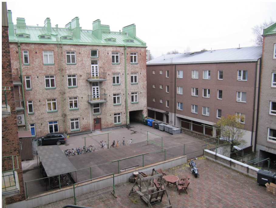
Kuva 5) Sisäpihan epäjatkuvuuskohtana on kuvan betonielementtirakennus.
