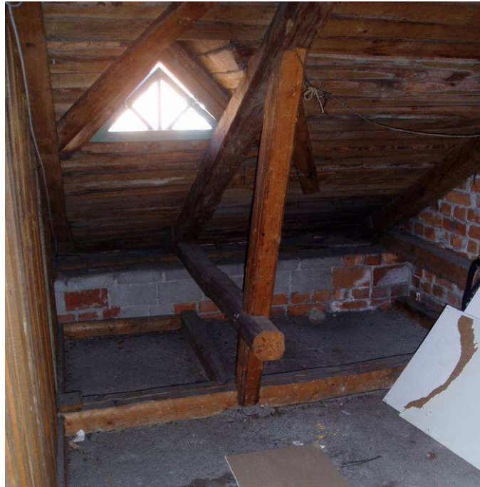
Kuva 8) Vesikaton rakenteet ovat alkuperäisiä.
