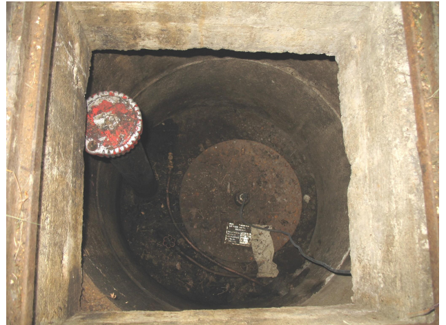
Kuva 2. Maanalaisen terässäiliön hoitokuilu.
