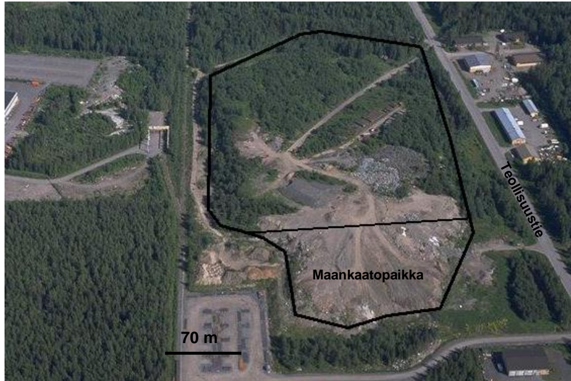
Kuva VI. Tampereella sijaitsevan Ikurin vanhan kaatopaikan jätteenkieren ja maankaatopaikan rajat vuoden 1998 viistoilmakuvassa. Suuri osa penkereestä on kasvillisuuden peitossa (Tampereen paikkatietotuotanto 2005).
