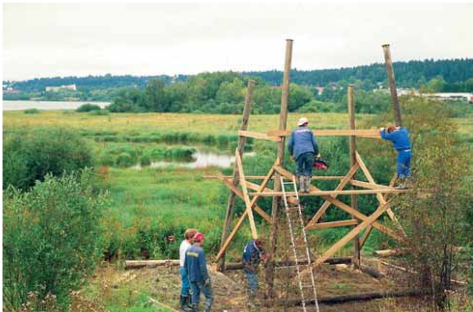
Iidesjärven lintutornin rakennustalkoot kesällä 1992.
