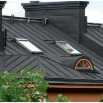
Yllä Lapeikkunoita ja vanhoja lunetti-kattolyhtyjä samalla katolla.
