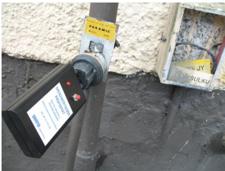
Kuva 8. Ylitäytönestimen toimivuuden tarkastaminen.
